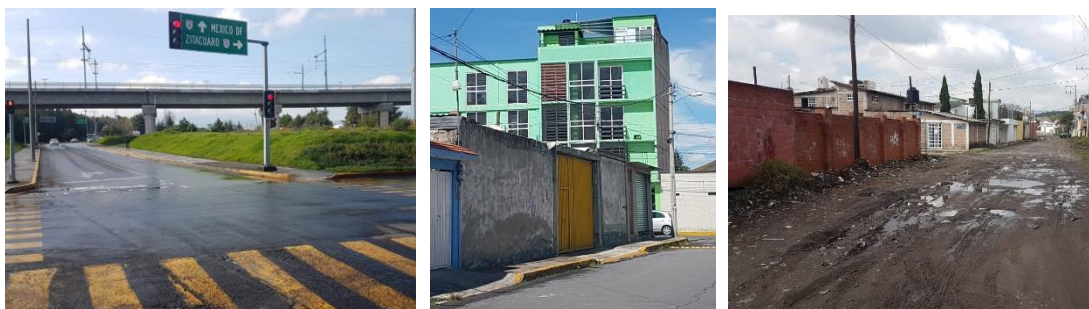
Fotografía 4.4 Estado actual de las vías
