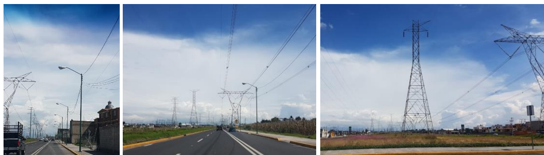
Fotografía 4.5 Infraestructura Eléctrica en la zona
