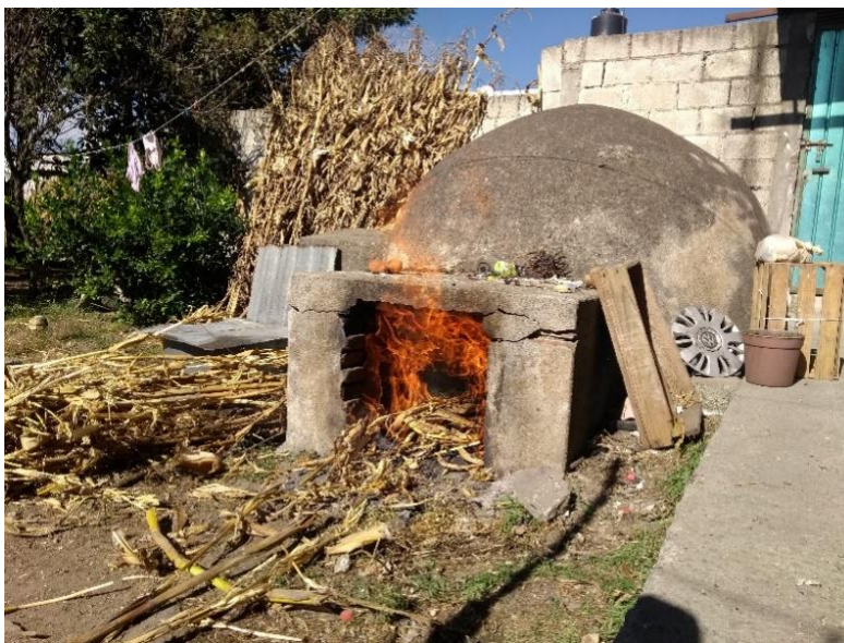
Ilustración 11. Baño tradicional con bóveda al momento de ser quemado con chinamites, la basura del maíz en Santa Ana Chiautempan (MVTM, 2017).
