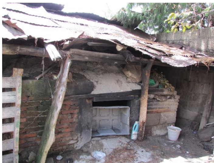
Ilustración 9. Baño de temazcal, conocido como "el de torito" se considera que son de los más antiguos de la región, el techo se compone de tablas, ocoxal y tierra (San Isidro Buen Suceso, MVTM, 2019).
