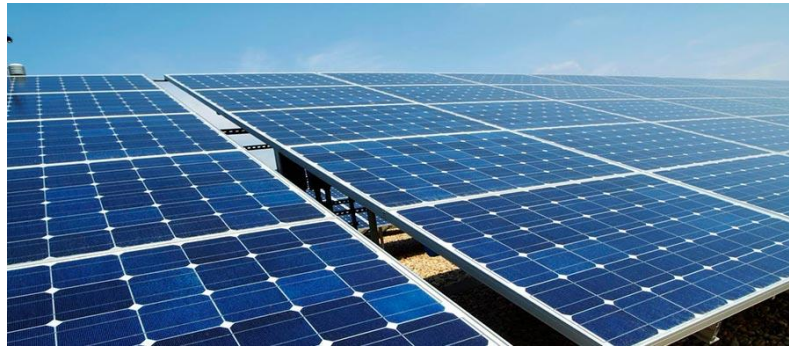
Figura 13. Módulos solares fotovoltaicos.
