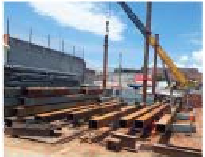
MONTAJE DE COLUMNAS HSS
