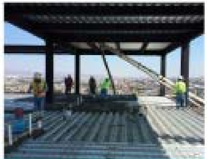
COLOCACIÓN DE LOSACERO
