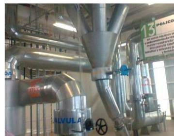
Figura 6.9: Las impurezas son removidas con nitrógeno y se prepara el sustrato para la cristalización y policondensación.
