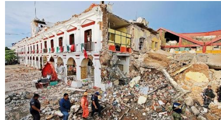
Figura 3.1. Daños ocurridos en el municipio de Juchitán por el sismo ocurrido el 07/09/17. Créditos: Mario Jiménez Leyva, https://www.nvinoticias.com/nota/72498/7-de-septiembre-el-dia-del-desastre-de-oaxaca .
