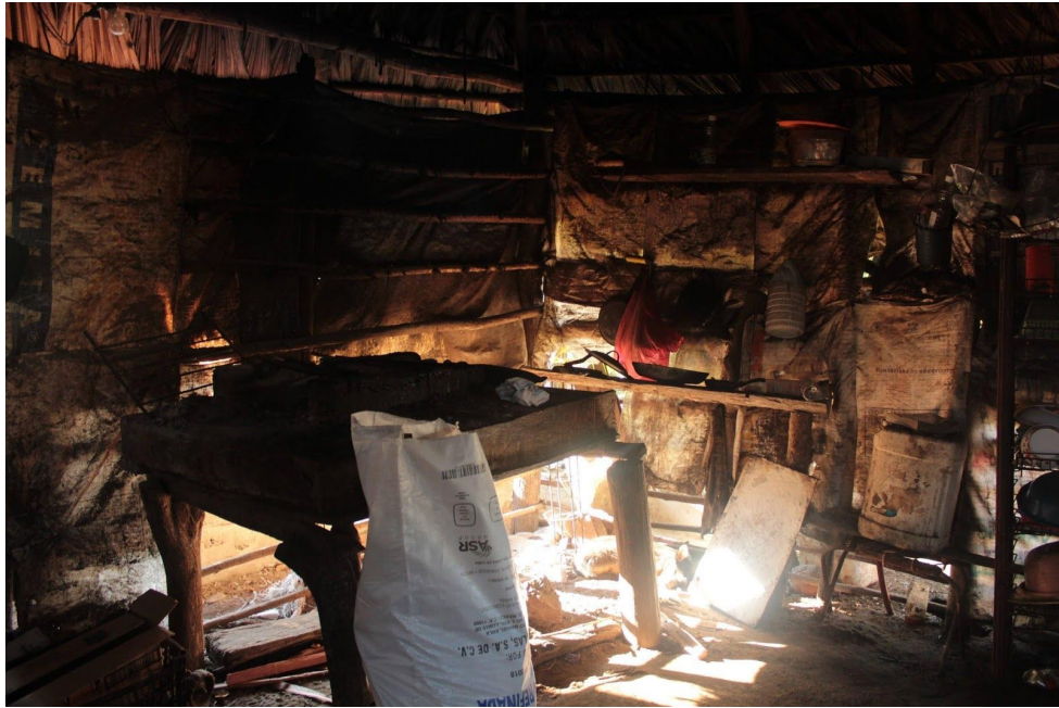
Figura 28. Imagen de un fogón en un espacio encerrado, con el mínimo de ventilación; el interior de la cocina está construido con madera de mangle. Fuente: elaboración propia, 2019.
