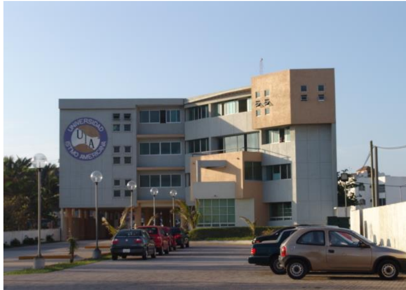
FOTO 5. Instalaciones actuales de la Universidad Istmo Americana (Campus FORUM)
