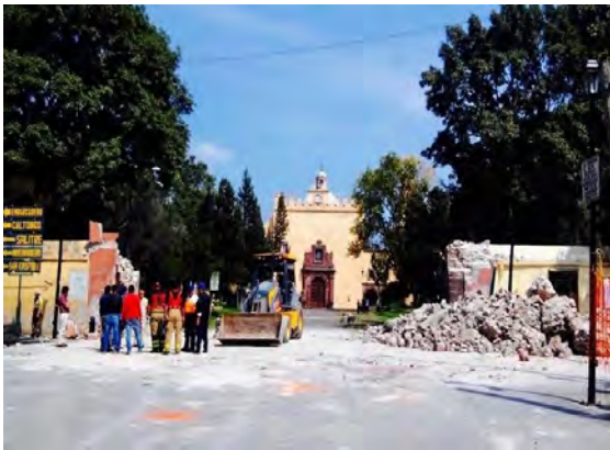
Fachada principal de la Iglesia, Foto propia tomada el 17 de septiembre del mismo año después del sismo.
