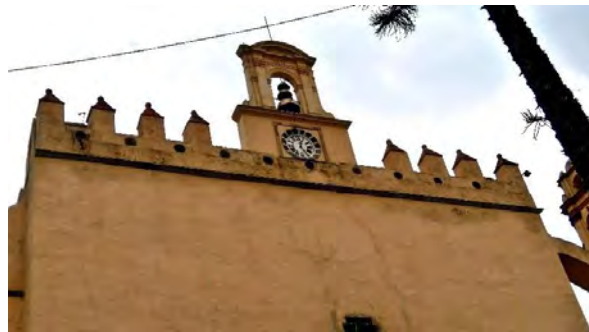
Vista de la fachada principal de la nave y de lo que fue una espadaña la cual fue sustituida por un reloj. Fotos tomadas en noviembre de 2016 por PRC.
