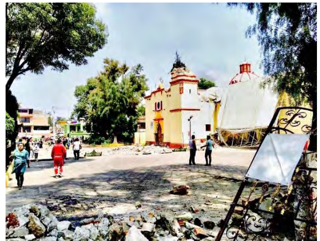
Iglesia del Pueblo de San Gregorio Atlapulco, Vista desde el acceso principal al atrio. Foto tomada por un vecino de la zona, septiembre de 2017, días después del sismo.
