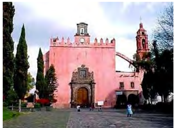
Fachada principal de la Iglesia de San Bernardino de Siena, noviembre del 2002, antes de ser pintada de amarillo en el 2005. Fuente: archivo de Fernando Chiapa Sánchez. Imagen citada de Arroyo Urióstegui, Ana Julia, tesis para obtener el título de Maestra en Historia del arte. . . , p. 22.
