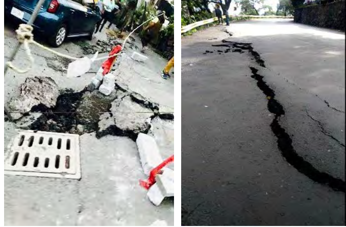
Carretera Xochimilco- Tulyeahualco, grieta de gran dimensión y levantamiento del piso. Foto tomada por un vecino de la zona, septiembre de 2017.
