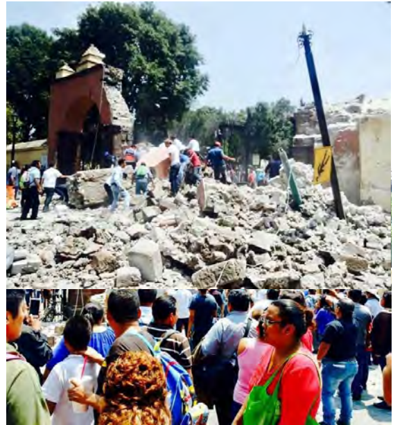
Arcos de acceso al conjunto conventual por el atrio, Foto tomada por vecinos de la zona el día del sismo, donde se puede ver el trabajo de la población al ayudar con los escombros.
