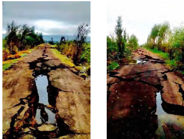
Carretera Xochimilco- Tulyeahualco, grieta de gran dimensión y levantamiento del piso. Foto tomada por un vecino de la zona, septiembre de 2017.
