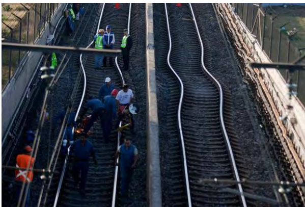
Foto tomada del artículo, Sismo de 7.89 grados: 11 heridos y cientos de viviendas afectadas en Oaxaca y Guerrero, proceso.com.mx
