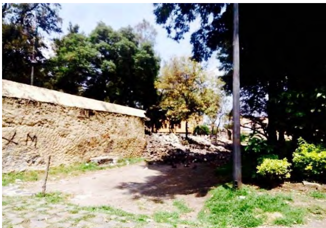
Barda perimetral vista desde el atrio, Foto propia tomada el 19 de septiembre de 2017, horas después del sismo.
