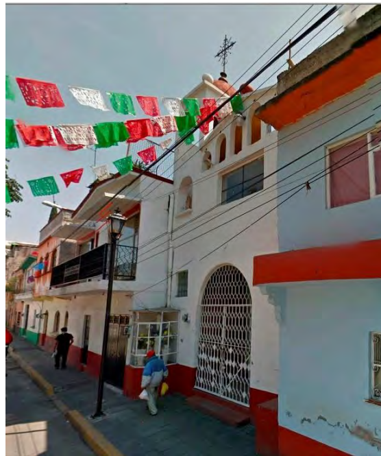
Fotografía de la fachada principal de la capilla de la Guadalupe, podemos ver que esta colinda con dos casas y puede pasar desapercibida tomada de google maps.
