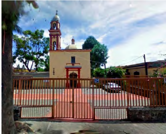
Fachada principal de la capilla de San Marcos por PRC.
