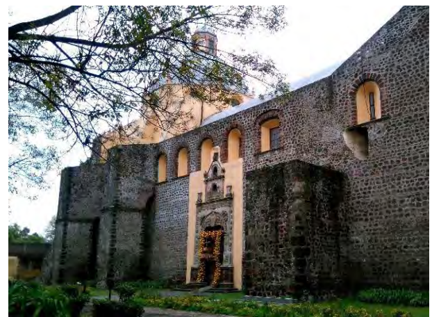
Contrafuertes en la nave principal de la iglesia de San Bernardino de Siena, noviembre 2016 por PRC.
