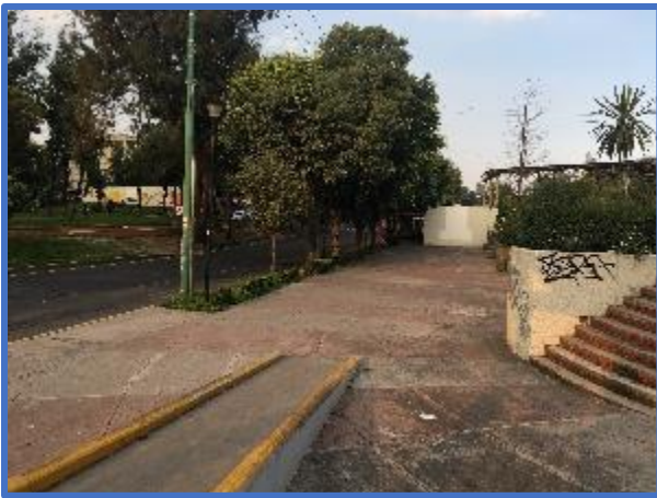
3. Vista bajando del puente peatonal hacia el predio.
