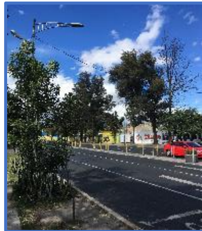
16. Cruce peatonal hacia el predio desde calle Hualquilla
