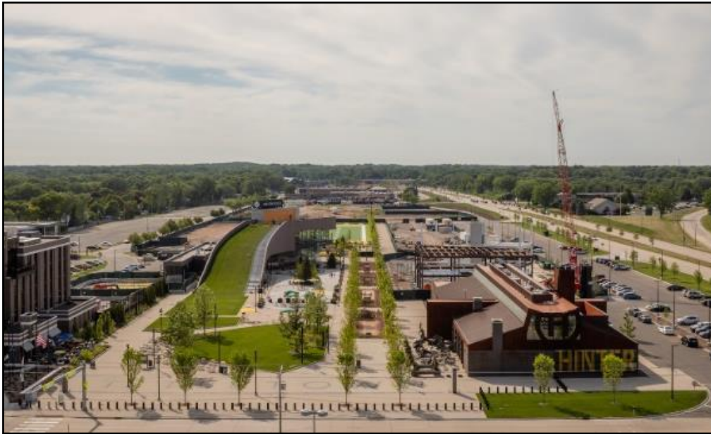
Ilustración 77. Fotografía aérea del Desarrollo deportivo Green Bay. Green Bay Packers Titletown District Sledding Hill
