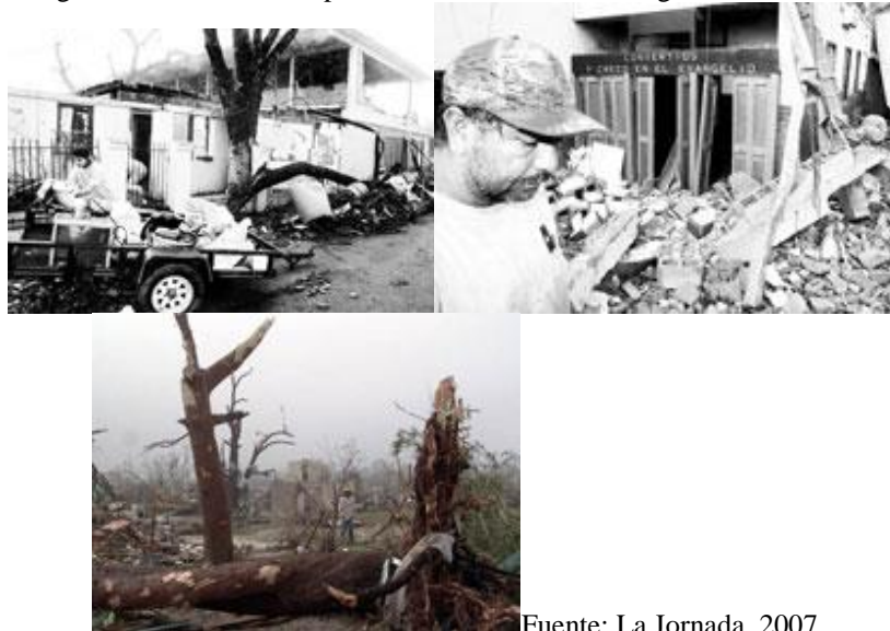
Imagen 1.11 Afectaciones por el tornado de Piedras Negras, Coahuila, 2007
