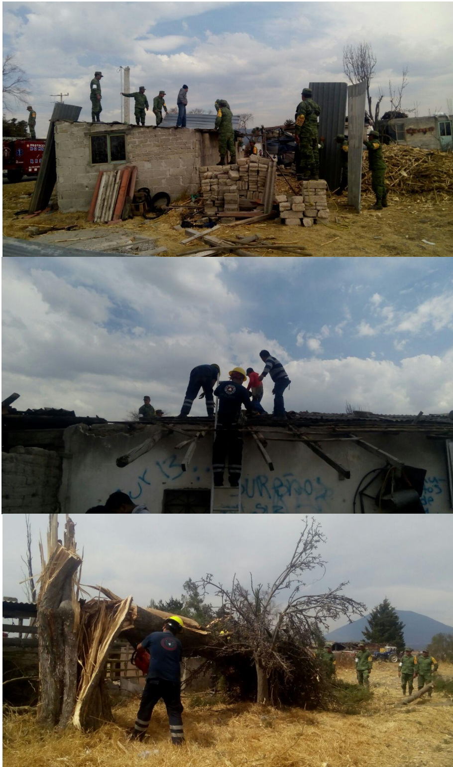
Fuente: Protección Civil del municipio
