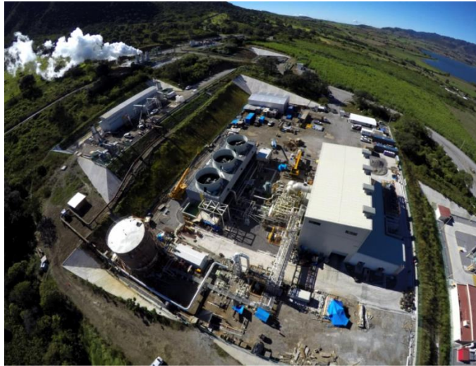
Fig. 18 Campo geotérmico Domo de San Pedro, Nayarit, México (tomada de piensageotermia.com ).
