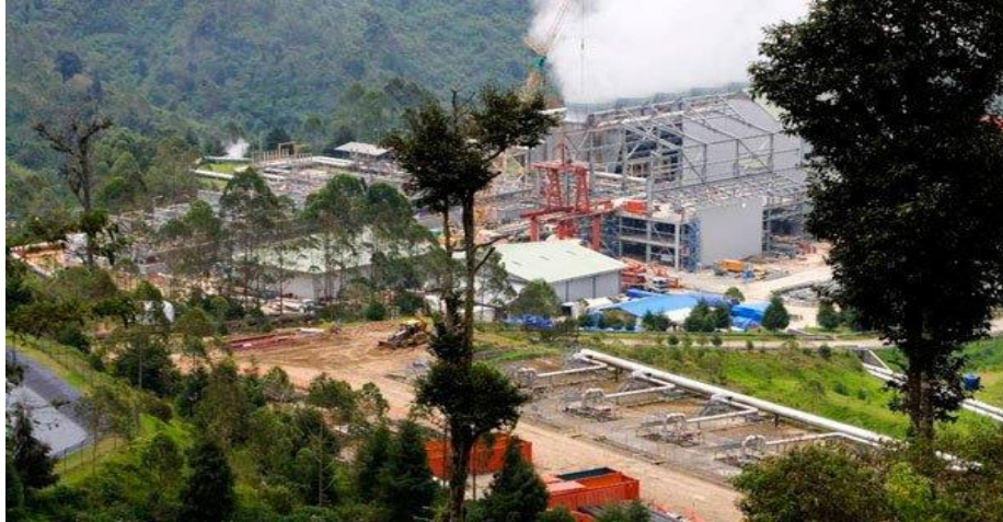
Fig. 10 Complejo geotérmico, Darajat (tomada de tninkgeoenergy.com).
