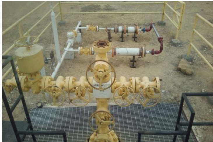
Fig. 4 Sistema integral de productividad de pozos (tomada de Instalaciones Superficiales, CSIPP).
