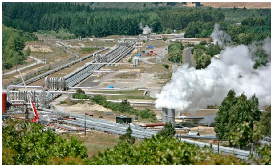
Fig. 11 Complejo geotérmico, Wairakei (tomada de tninkgeoenergy.com).
