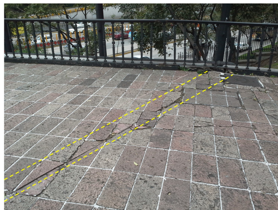
(c) Detalle del fracturamiento en adoquines
