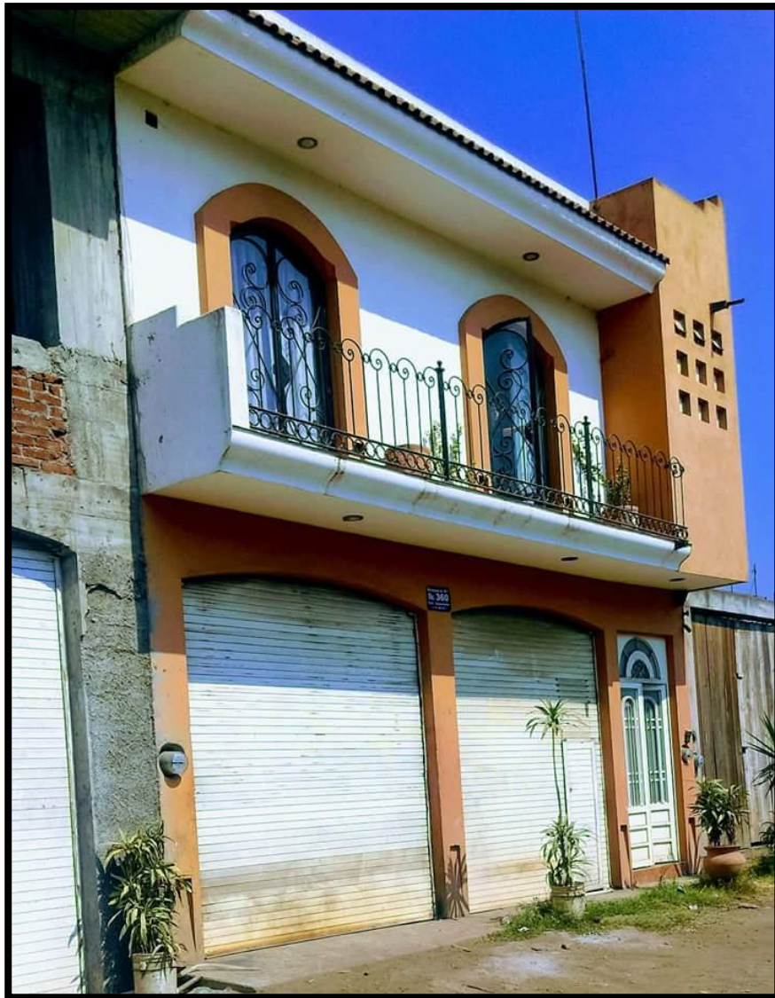
Figura 3.7. Fachada principal de la edificación.
