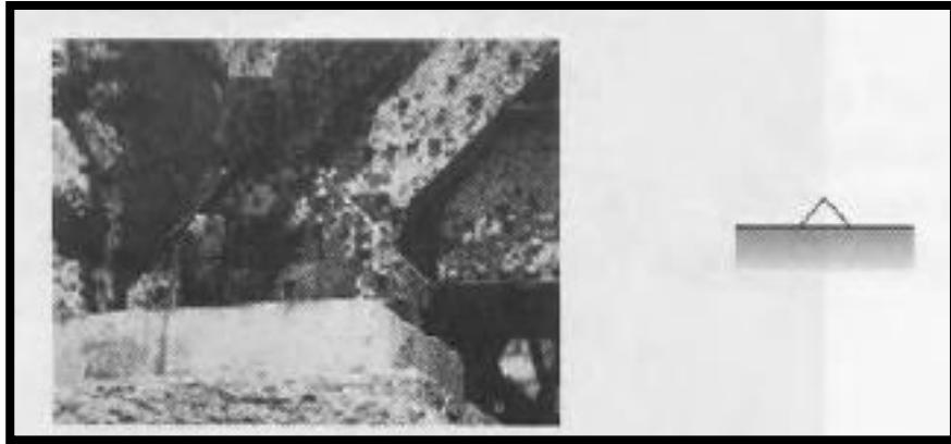
Figura 1.13. Símbolo común de un apoyo fijo.
