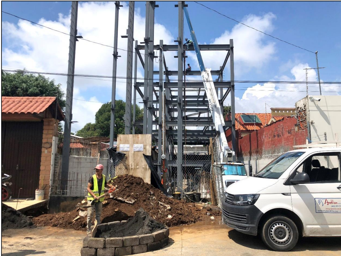
Foto 3.3.- Vista frontal del lugar de los trabajos.
