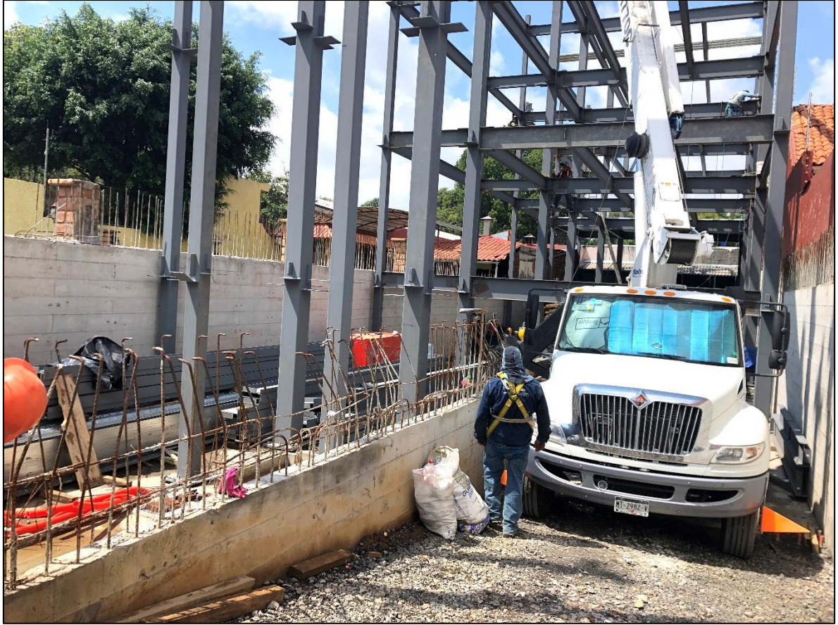
Foto 3.4.- Área de la realización de los trabajos.
