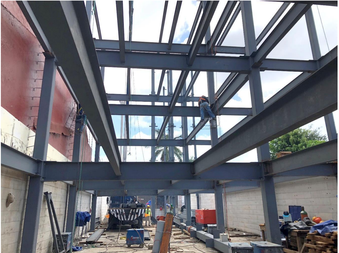
Foto 3.5.- Estado físico actual de la superestructura.
