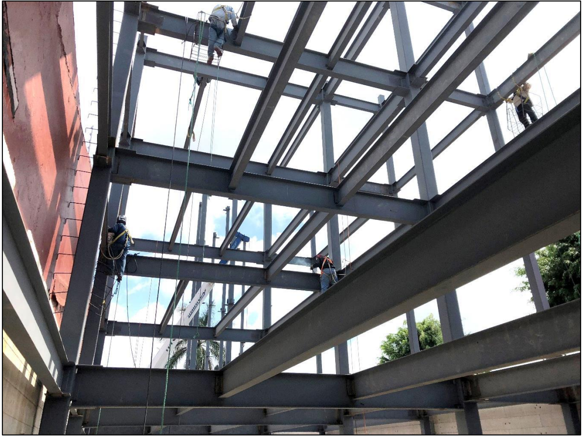
Foto 3.6.- Montaje de perfiles en la superestructura.
