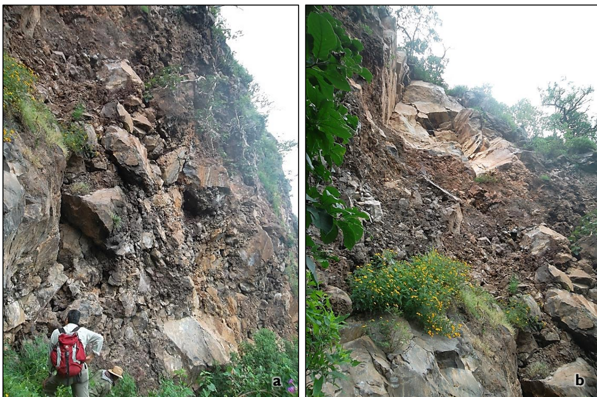
Figura 5.11 Litología de la zona de desprendimiento: (a) porción superior de la ladera compuesta por flujos de lava y brecha volcánica; y (b) vegetación y superficie de falla en forma de cuña en la cima del macizo rocoso. Fotografías: capturadas en septiembre, 2017.
