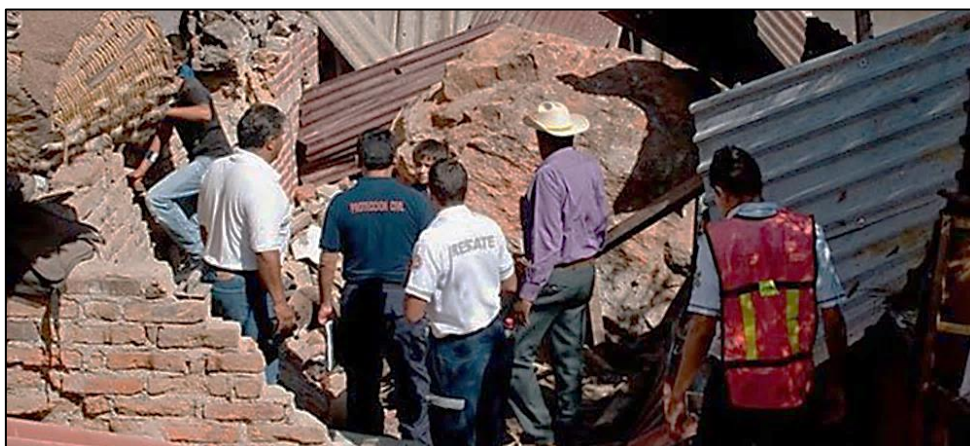
Figura 3.10 Daños que ocasionó la roca proveniente del cerro La Estrella. Fotografía: Quadratín, 2013.
