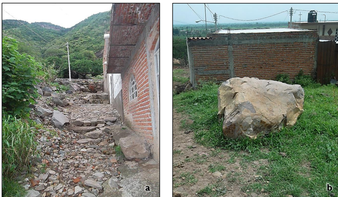
Figura 5.13 Litología de la zona de depósito: (a) la mancha urbana de Pajacuarán se desarrolla sobre la ladera y zona de depósito de bloques; y (b) bloque mayor a 2 m de diametro ubicado al pie de la ladera. Fotografías: capturadas en julio, 2018.
