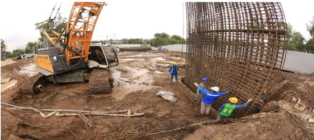
*Figura 1.6 Colocación de refuerzo del Muro Milán en la zanja de excavación*
