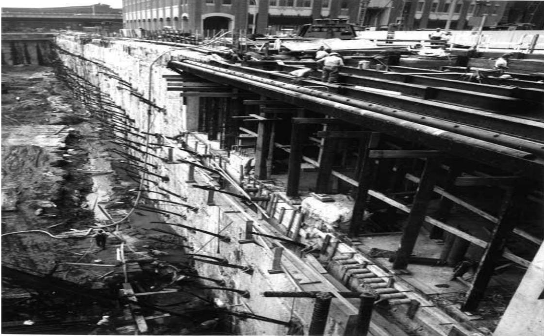
*Figura 1.2 Construcción del muro Milán para el WTC-NYC (<http://collections.mcny.org>)*
