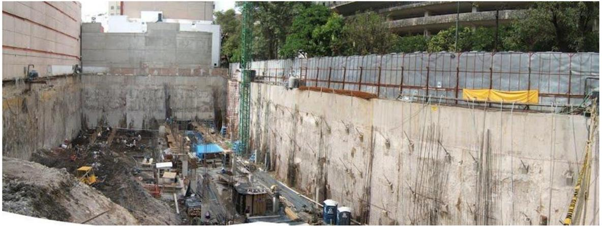
*Figura 1.8 Muro Milán para una Cimentación en la Ciudad de México*
