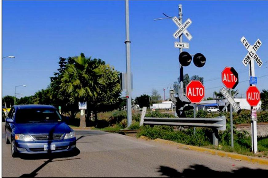
Figura 8. Protecciones en Cruce a Nivel.
