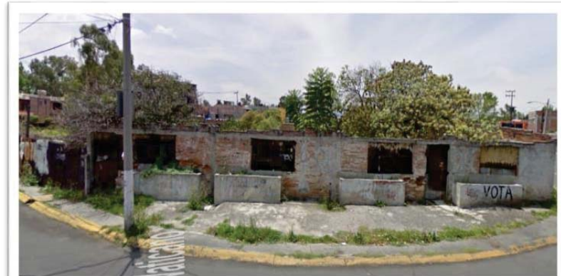
Ilustración 36. Fachada este avenida Milán - Vaticano
