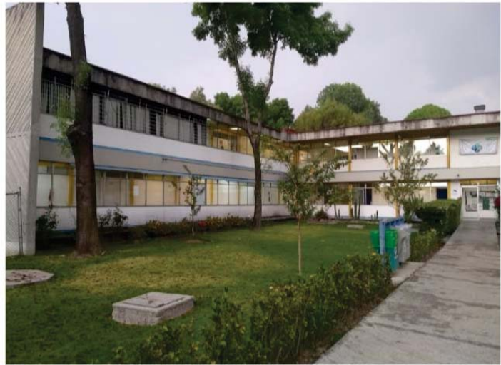
Ilustración 20- Fachada posterior- acceso administrativo- universitario
