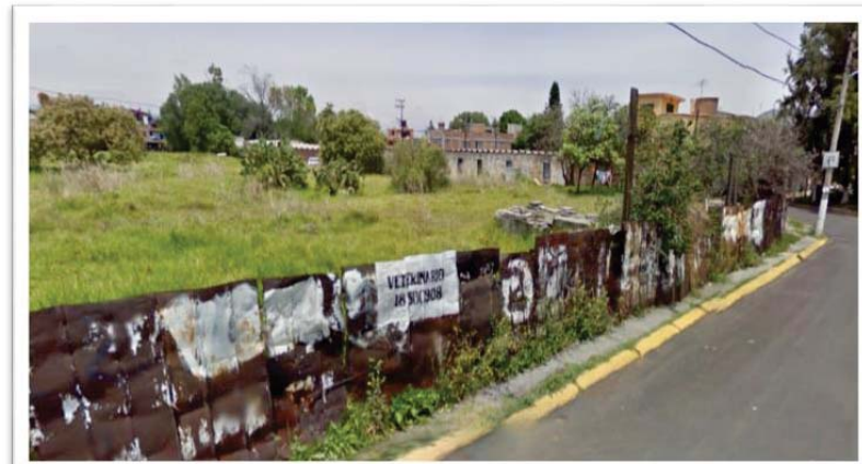
Ilustración 38. Fachada oeste avenida Vaticano
