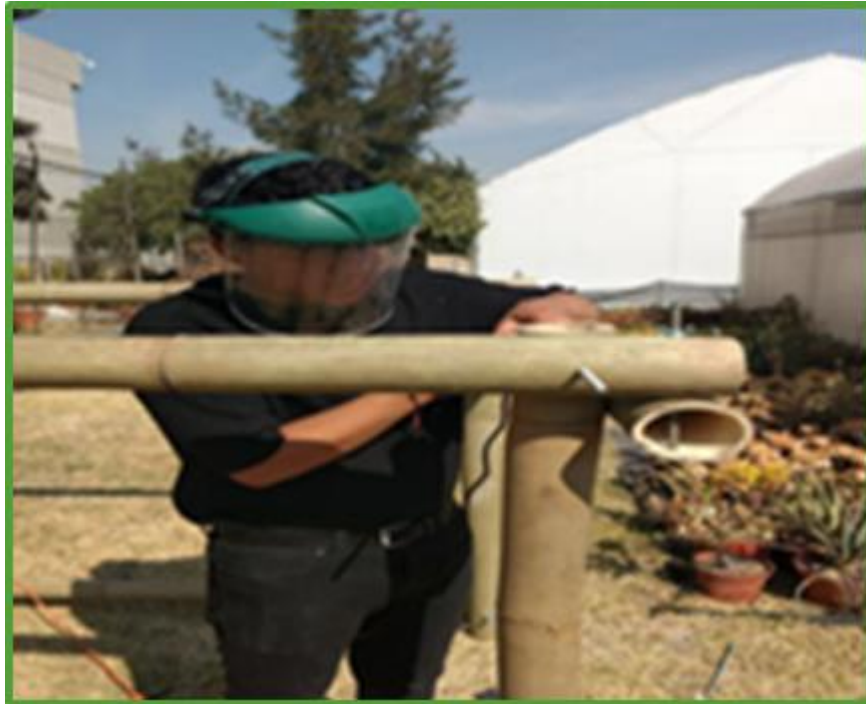
Figura 3.21. Colocación del segundo marco de bambú.
