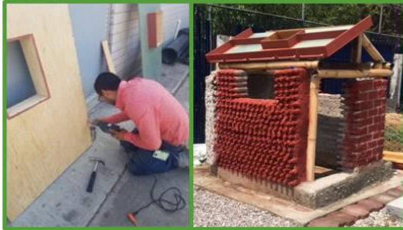
Figura 3.27. Construcción y montaje del techo.
