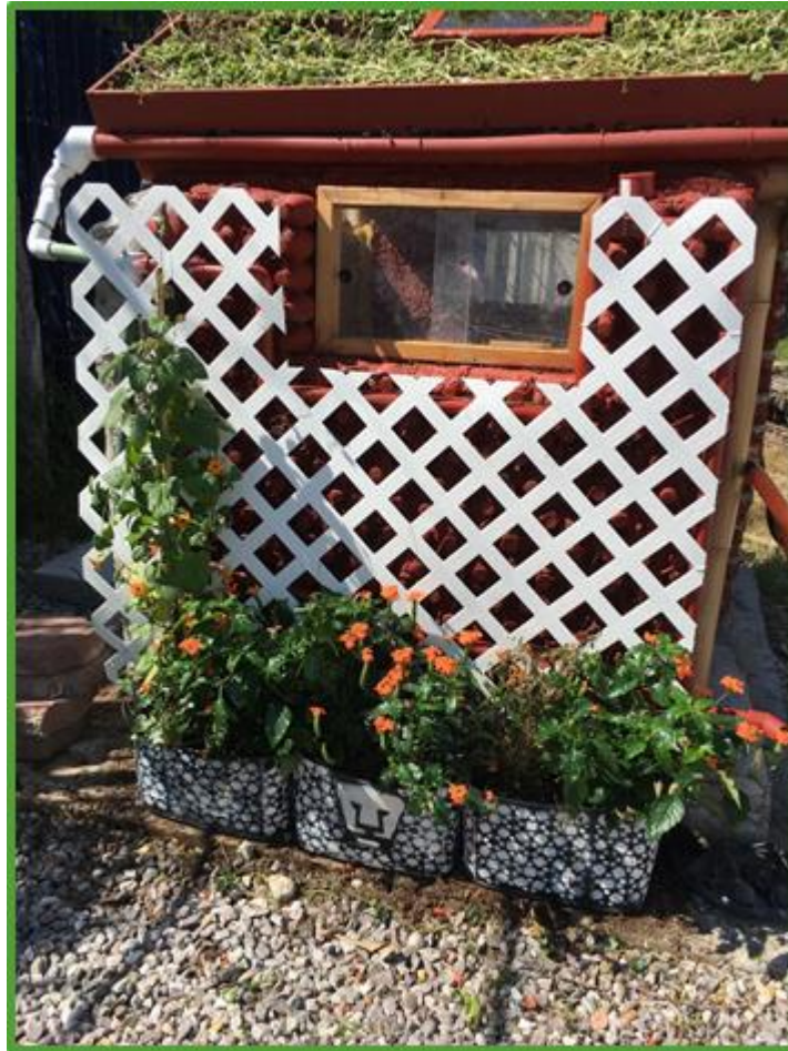
Figura 3.36. Fachada Indirecta con reja.
