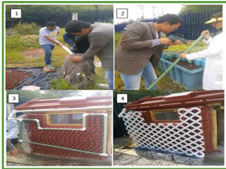
Figura 3.33. Elaboración de soporte para pared indirecta.
