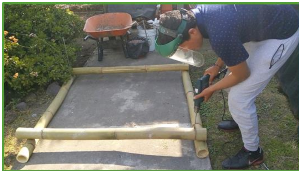
Figura 3.20. Construcción marco de bambú base.
