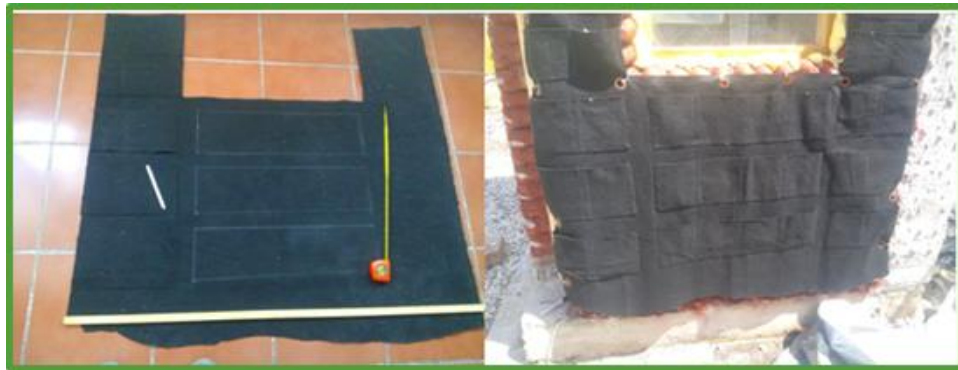
Figura 3.30 Geotextil como medio de soporte de un muro viviente.
