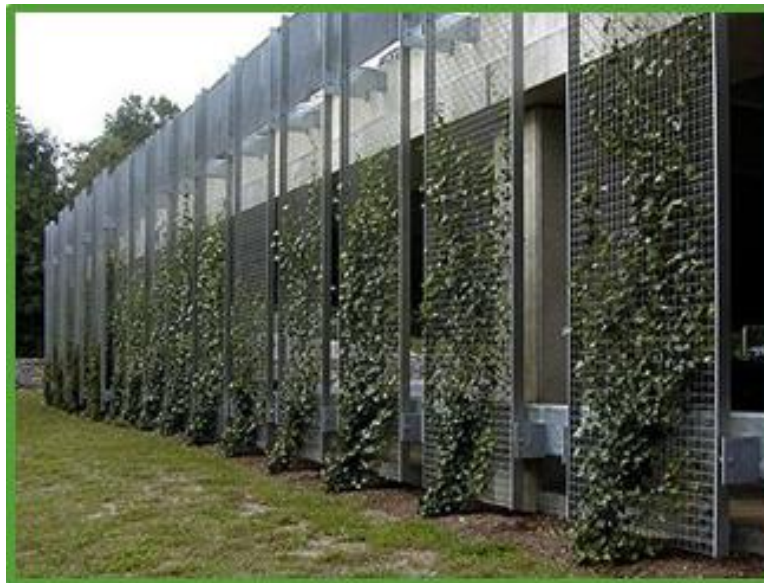
Figura 1.6. Estructura reticular y colocación de plantas escaladoras. Sin autor, 2018
