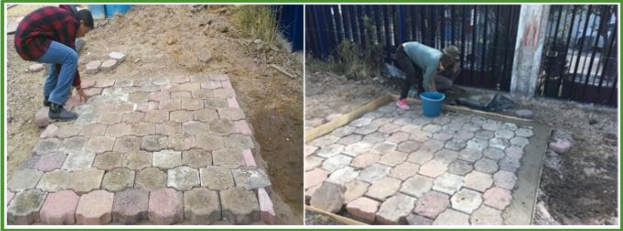
Figura 3.19. Colocación de la superficie de desplante con adoquín.
