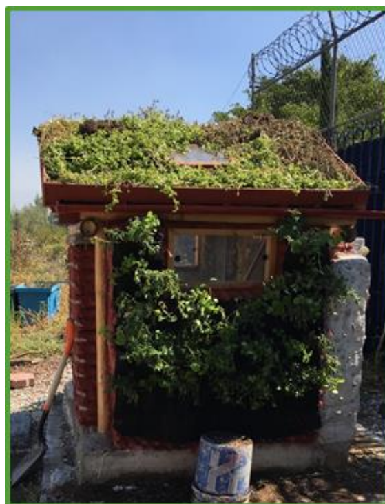
Figura 3.32. Muro viviente en la fachada oriente de la casa ecológica.
