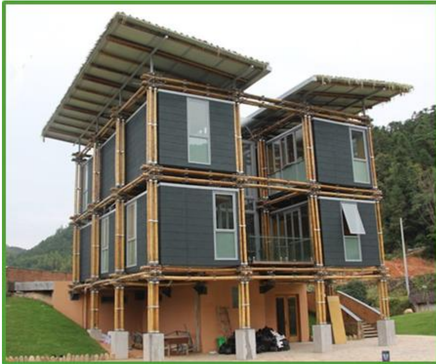
Figura 2.2. Casa hecha con bambú. Fuente: Ecoinventos. 2018.
