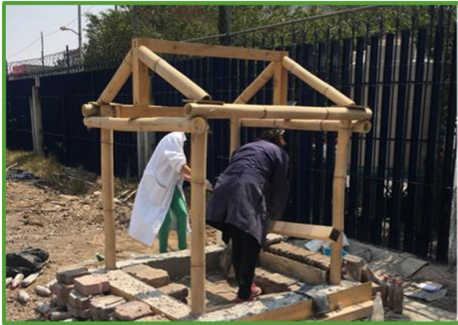
Figura 3.22. Estructura de bambú.
