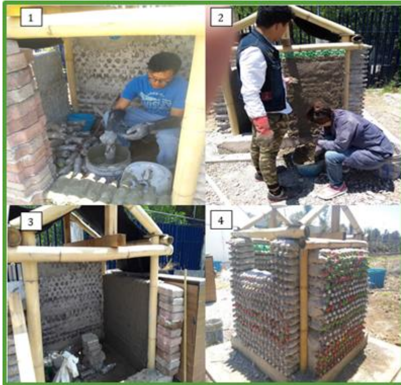
Figura 3.26 Construcción de muros de PET.
