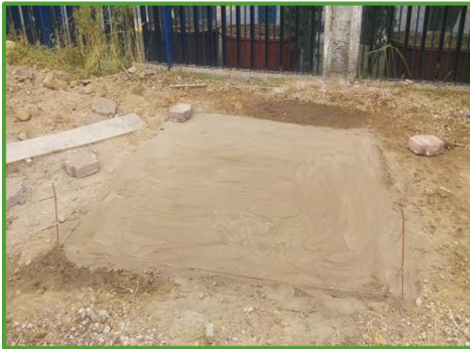
Figura 3.18. Nivelación del terreno.
