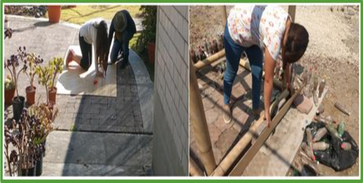
Figura 3.23. Construcción de cimbra para dala.
