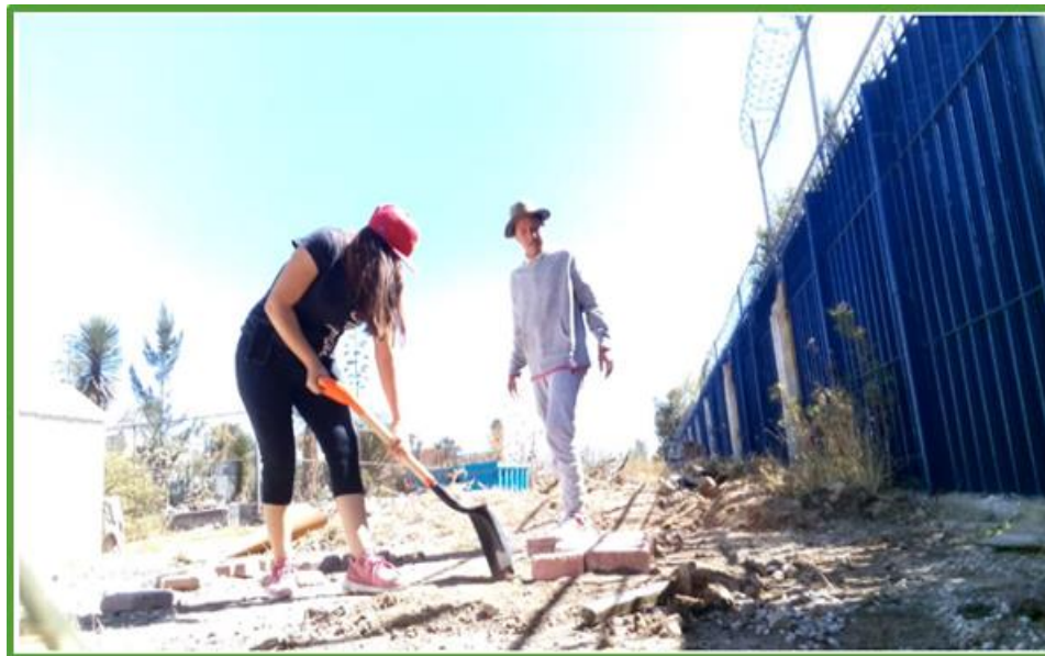
Figura 3.15 Limpieza del terreno.
