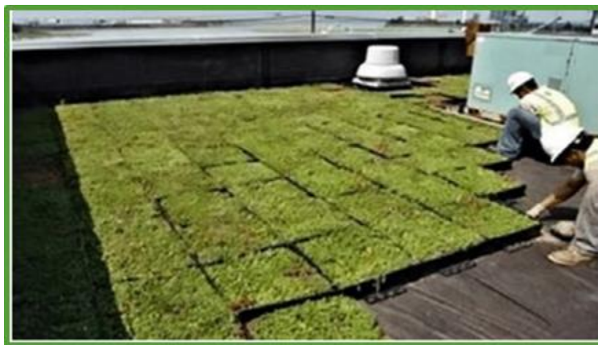
Figura 1.12. Proceso de Instalación de un techo verde modular. Fuente: Korol y Shushunova (2016)
