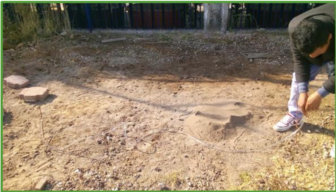
Figura 3.17. Nivelación del terreno con manómetro.
