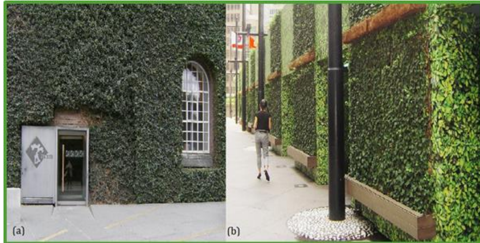
Figura 1.5. Clasificación de fachadas verdes: (a) fachada verde directo, casa particular, Golegã, Portugal., (b) fachada verde indirecta. Fuente : Manso y Castro ,2016.
