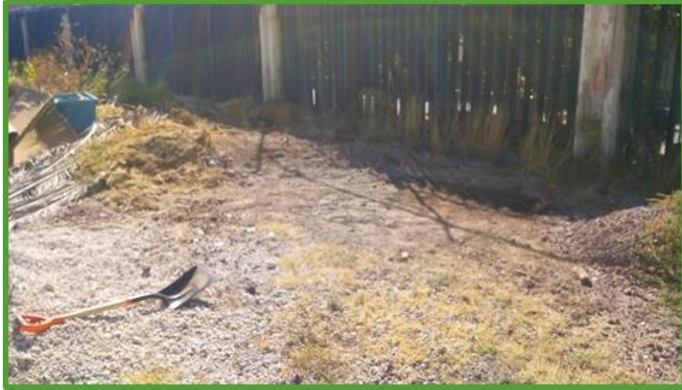
Figura 3.16 Terreno después de limpieza.
