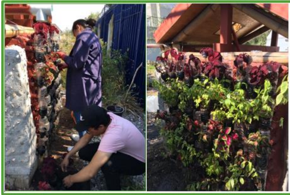
Figura 3.38. Pared viviente con sistema suelo-celda.
