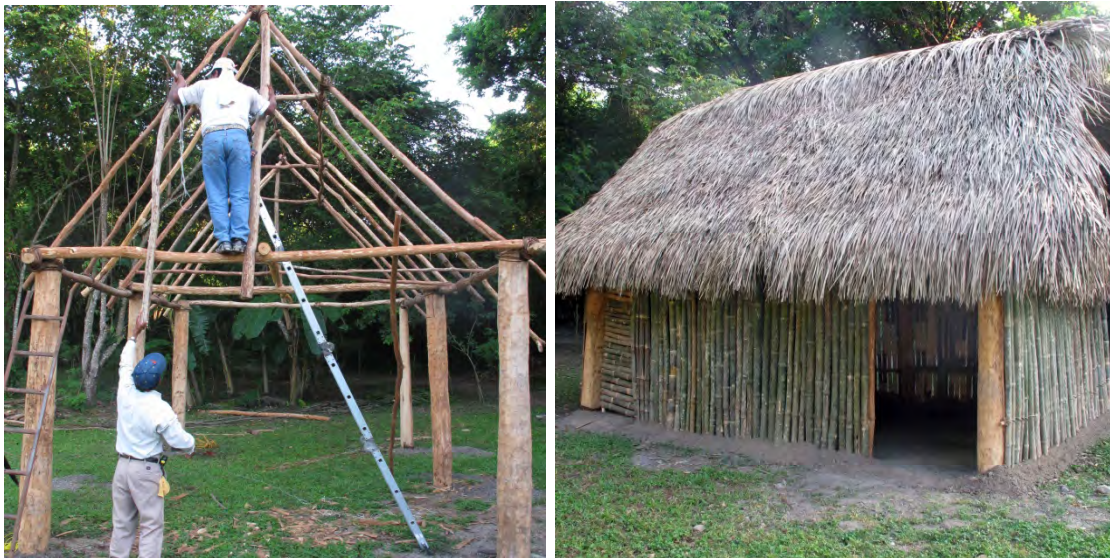
Figura 24.- Construcción de una casa típica de la región. Nótese que los materiales considerados para la cubierta son los mismos que se utilizan para la fabricación de sus viviendas por lo que la disponibilidad del material y mano de obra se vuelven factores a considerar en la proyección de la cubierta. Fotos del autor.
