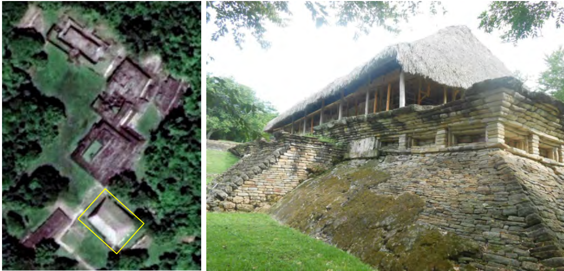
Figura 2.- Izquierda: Vista aérea 5 de la zona residencial “Tajín Chico” donde se encuentra el Edificio I (recuadro color amarillo). Derecha: Vista actual de la subestructura. Foto cortesía de la CNCPC-INAH.
