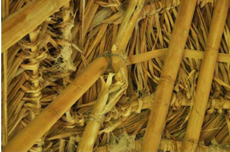
Figura 25.- Daño del bambú en la unión de elementos. Especial cuidado en las uniones no solo entre las varas del bambú, sino también con la madera, con el fin de evitar rupturas que pongan en riesgo la estabilidad de la estructura. Fotografía Benjamín Blaisot.
