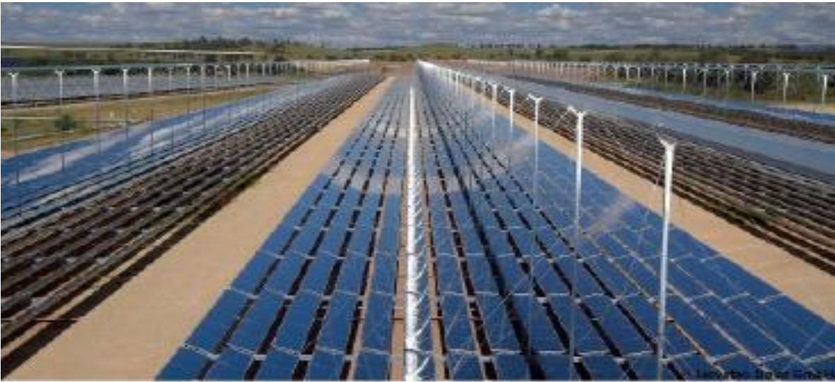
Reactor de concentración media; Concentrador lineal de espejos de Fresnel (UAI, 2019).
