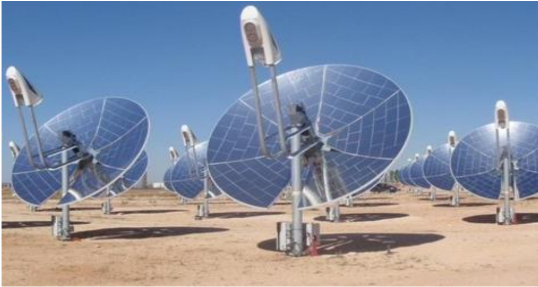
Reactor de concentración alta; Concentrador de disco parabólico (SitioSolar, 2019)
