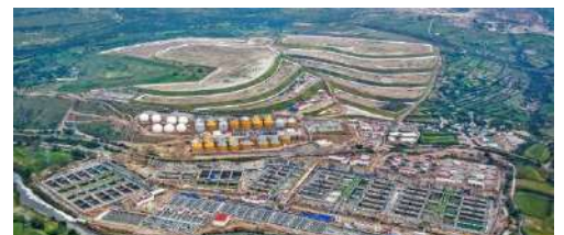
2.26 Planta de tratamiento de aguas residuales en Atotonilco, Fuente: Acciona AGUA
