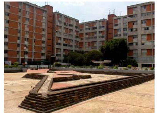
2.19 Unidad habitacional Foviste Copilco, Fuente: Navegando la arquitectura.
