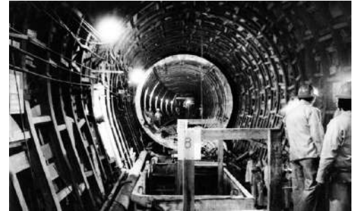
2.21 Obras del drenaje profundo de la Ciudad de México, Fuente: UNAM
