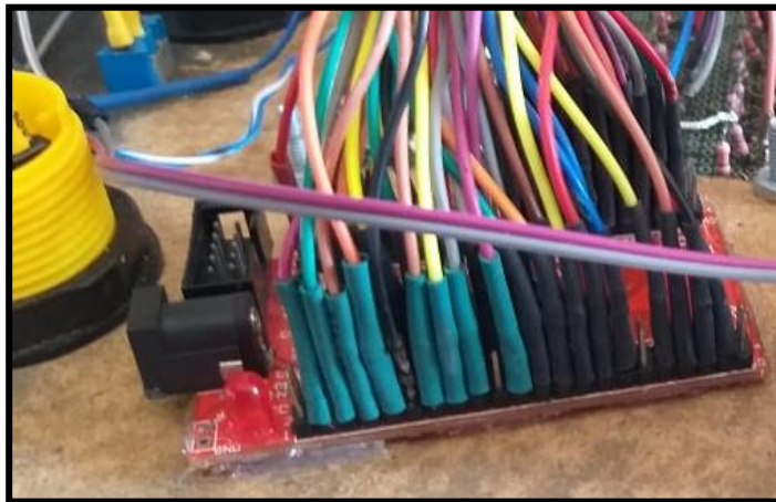
Figura 3.7. Conexiones cubiertas con termofit.
