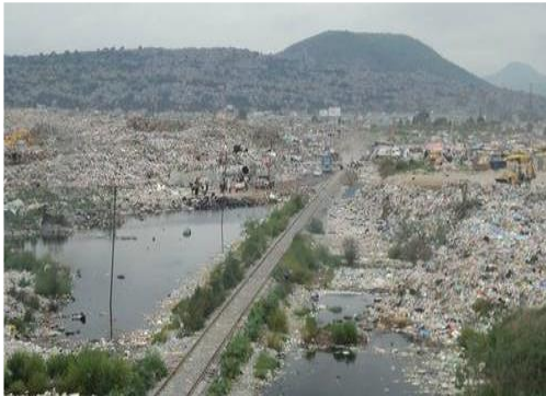
Ex Tiradero de Residuos Sólidos antes del Saneamiento
