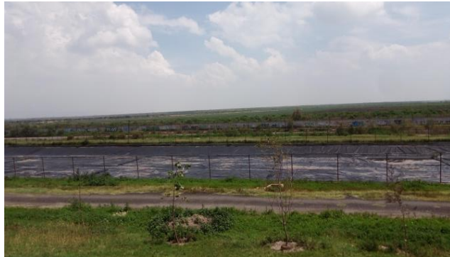
Ex Tiradero de Residuos Sólidos Clausurado y Saneado
