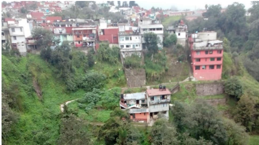
Figura 2.13 Ampliación de la Cerrada de Emilio Carranza, Colonia La Gloria, foto autoría propia, noviembre 2018.
