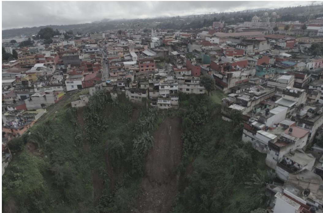
Figura 4.14 Fotografía del deslizamiento ocurrido en el fraccionamiento Siete Sabios, trabajo de campo noviembre, 2018.
