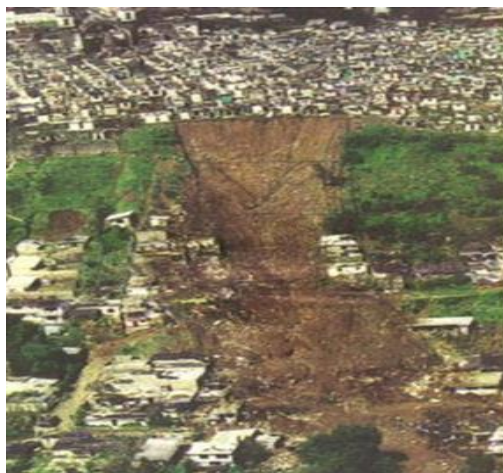
Figura 1.10 Deslizamiento en la colonia La Aurora, tomado de Alcántara-Ayala et al , (2001).
