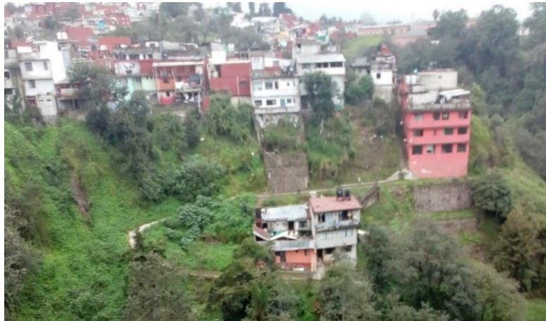
Figura 5.1 Ejemplo de viviendas donde se observa que de los niveles construidos, dos niveles son de cimientos (mampostería). Foto autoría propia noviembre, 2018.
