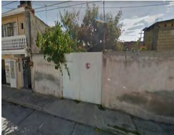
Imagen 14.- Fuente: Fotografía en sitio de fachada de vivienda de calidad regular.
