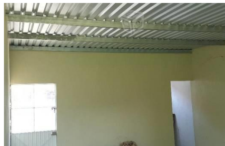
Imagen. 37 vivienda 2 techo de lámina
