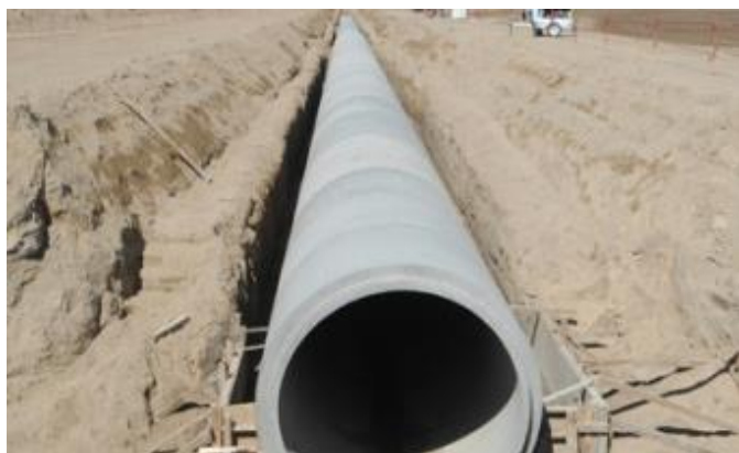
Imagen. 34 tuberías de Concreto Simple Alcantarillado.
