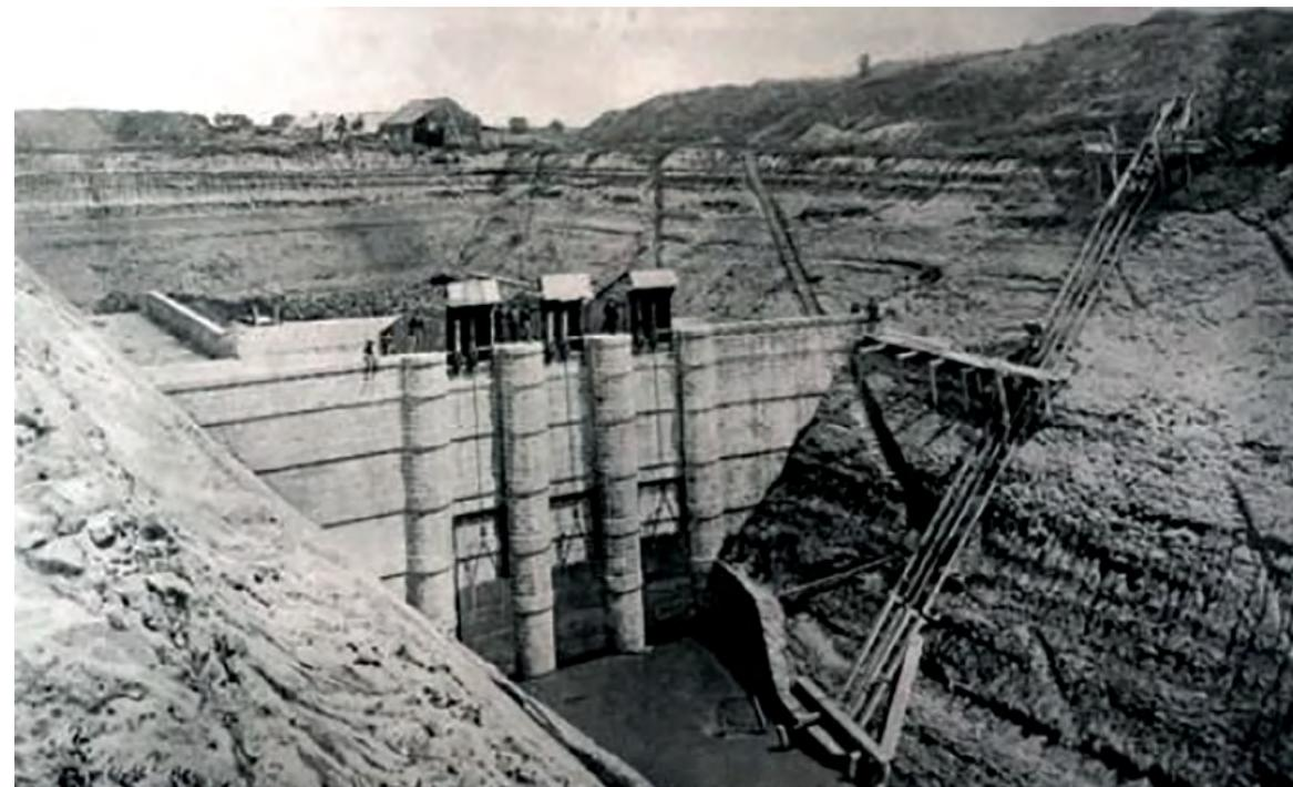
**CASASOLA. (1945). PRESA Y COMPUERTAS DEL TUNEL, EL GRAN CANAL DEL DESAGÜE. FIG. 3.3.**
