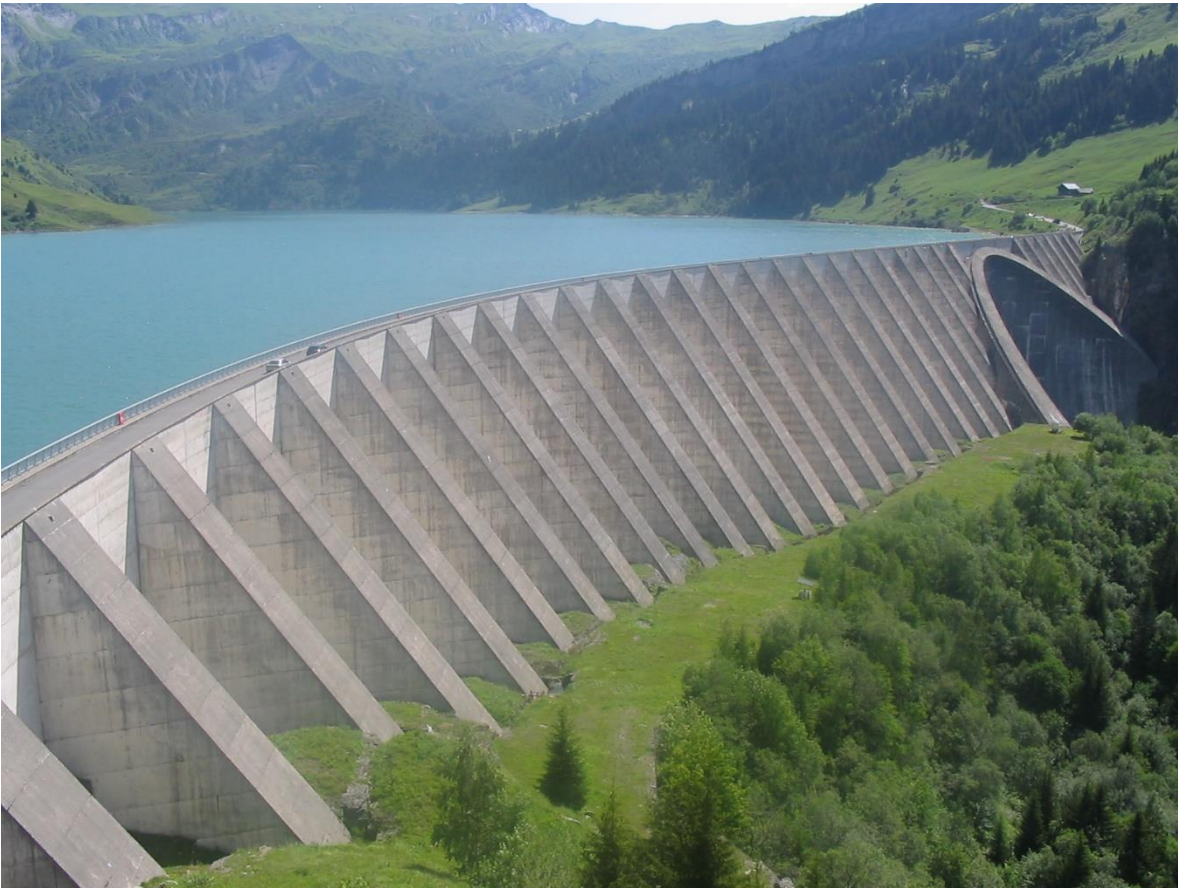
Fig 1.4 Presa de concreto con contrafuertes Roselend ubicada en Beaufort, Francia (Versgui, 2017).
