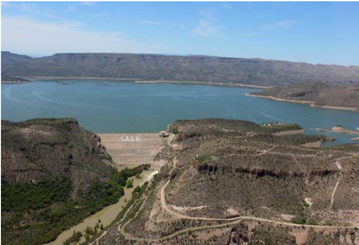
Fig 1.2 Presa de tierra y enrocamiento Lázaro Cárdenas ubicado en la confluencia de los ríos Ramos y Del Oro en el estado de Durango (Alcalá, 2016).
