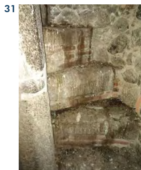
Imagen 231. Escaleras de campanario.
