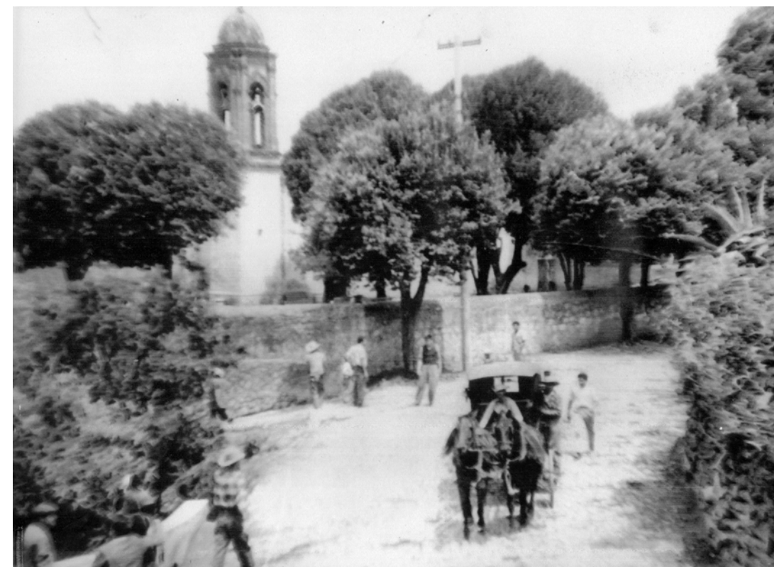
Imagen 25. Vista del puente hacia la iglesia.
