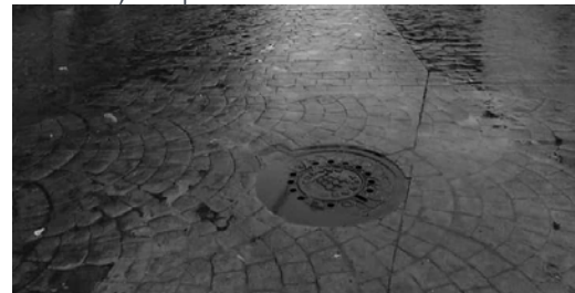
Imagen 133. Coladeras del drenaje público.
