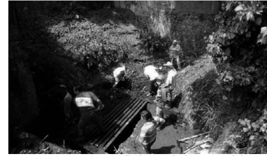
Imagen 147. Trabajos de limpieza del canal.
