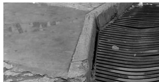
Imagen 134. Coladera del drenaje público.
