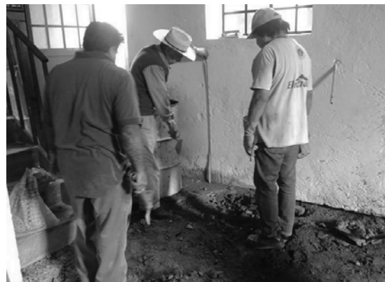
Imagen 13. Estado de salones que forman parte del conjunto religioso.
