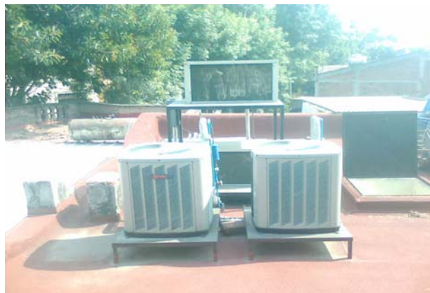
Fig. 32 Condensadores
