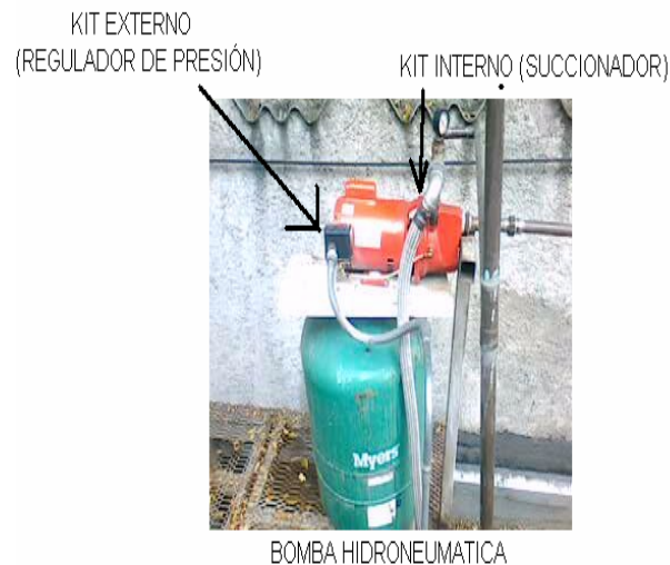
Fig. 30 Bomba hidroneumática mostrando la posición física del kit interno y kit externo.
