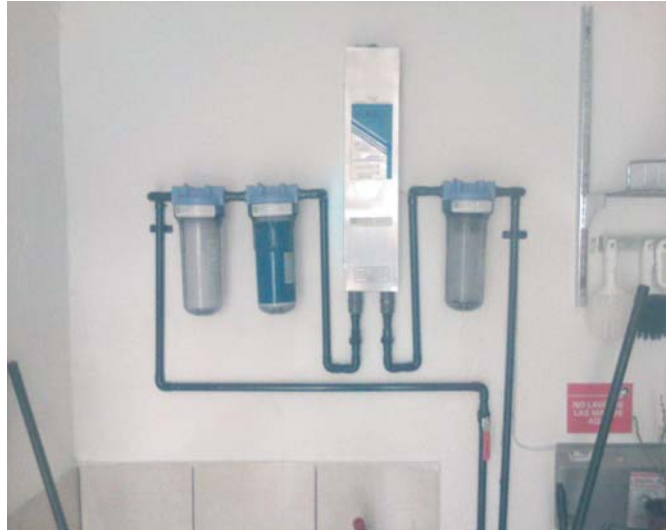
Fig. 35 Conexión de los filtros de izquierda a derecha su orden es: filtro de cerámica, filtro de carbón activo, lámpara uv y finalmente el filtro de sales.
