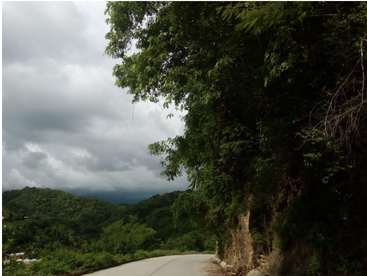
Figura 37.- Carretera costera federal 200. Municipio de Santa María Huatulco. Fotografía propia.
