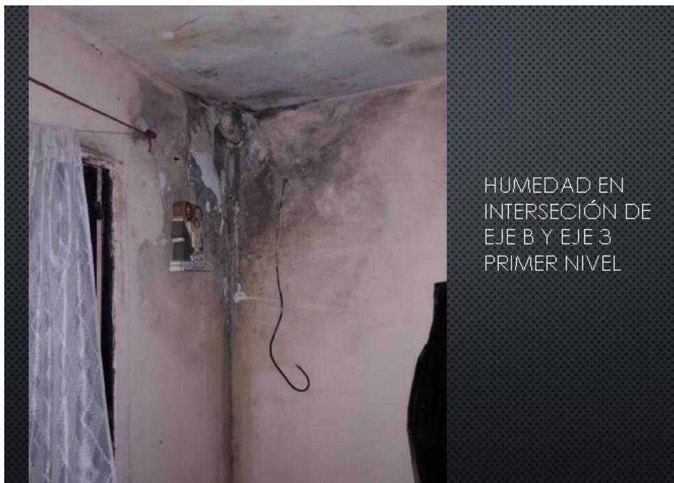
Figura 38 Humedad en intersección de eje B y eje 3 en primer nivel
