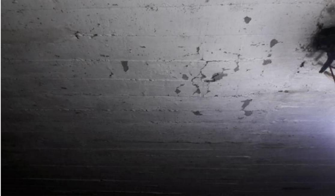
**Figura 35 Desconche de concreto en losa**
