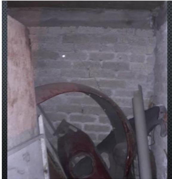
**Figura 18 Grietas en muros de segundo nivel entre eje 3 y 4 del eje C**
