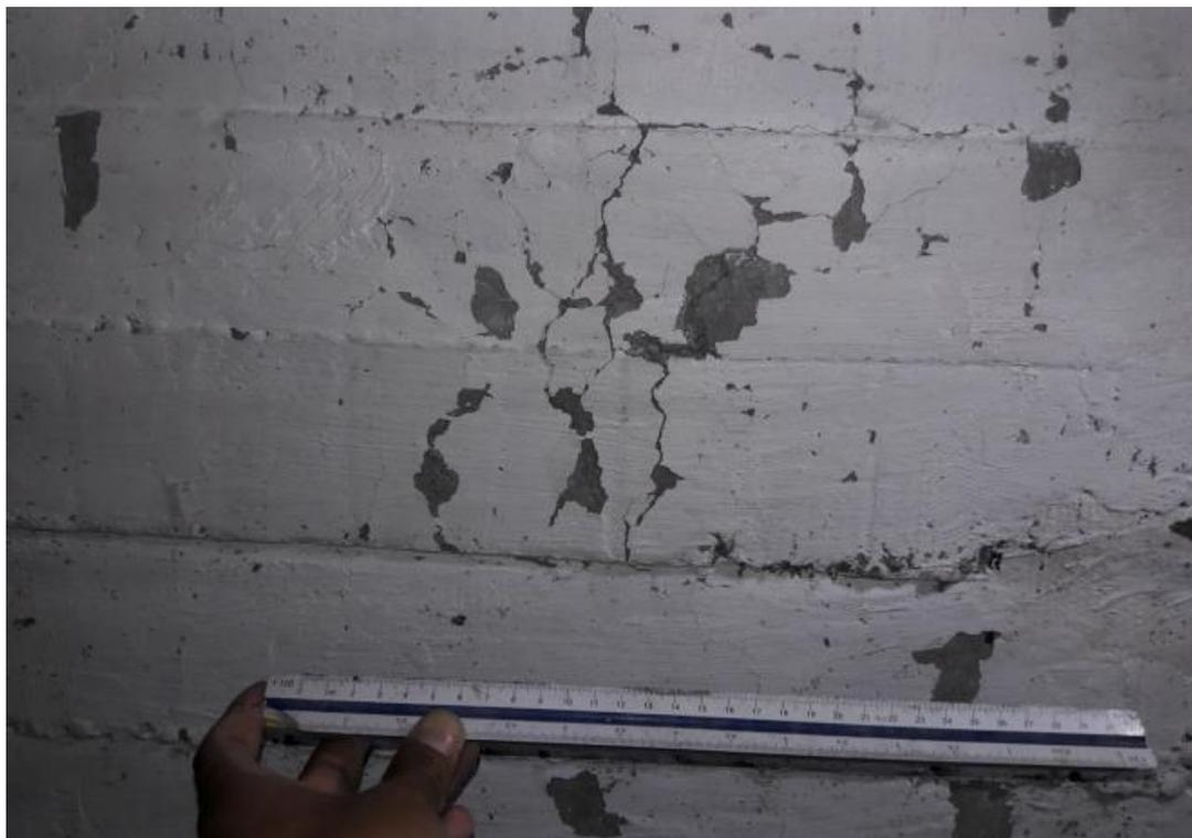
**Figura 36 Desconche de concreto en losa**
