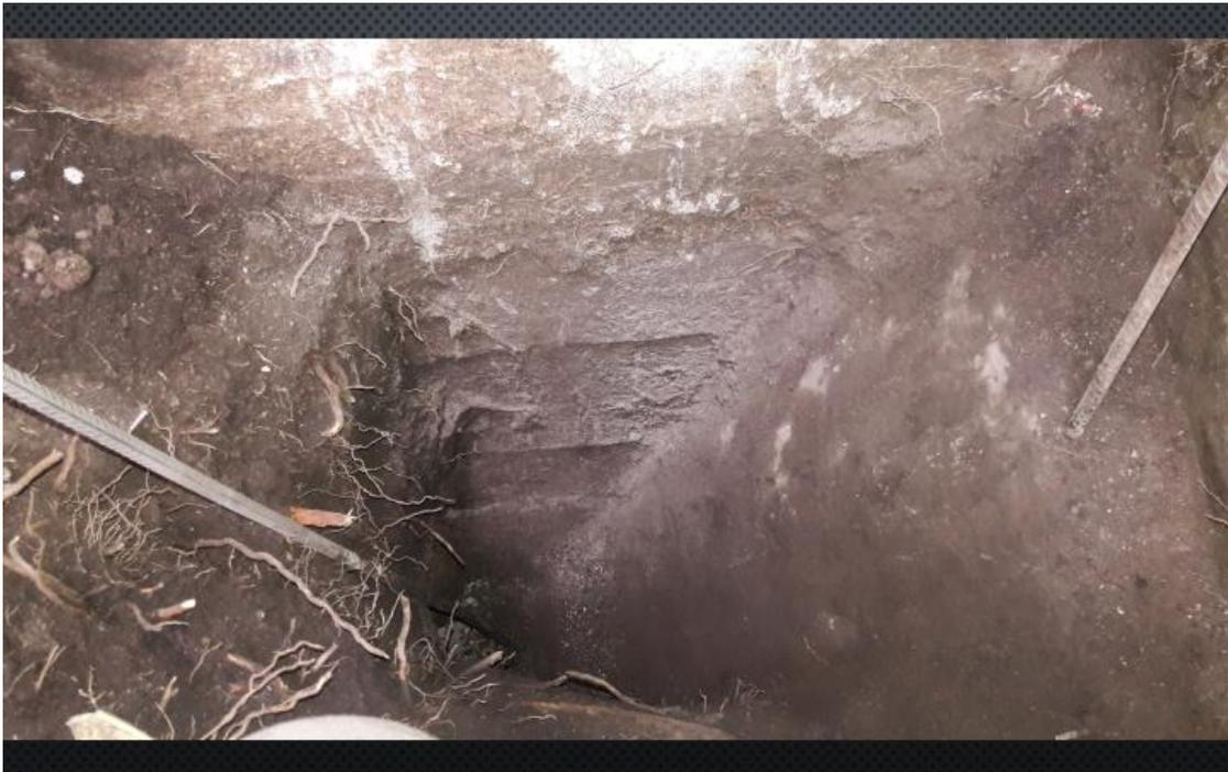
**Figura 42 Cala de verificación de cimentación**
