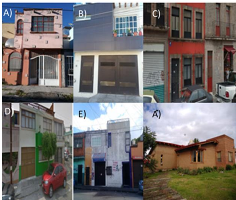
Figura 3. Viviendas seleccionadas para el estudio; Sistema constructivo convencional A, B, C, D y E en el orden de la foto y el sistema constructivo alternativo A* al final de la misma
