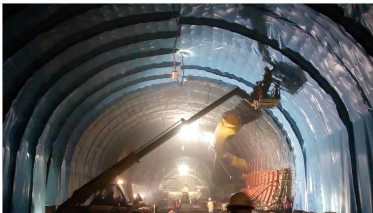
Figura 3.4: Impermeabilizante colocado después del CLR en túnel.
