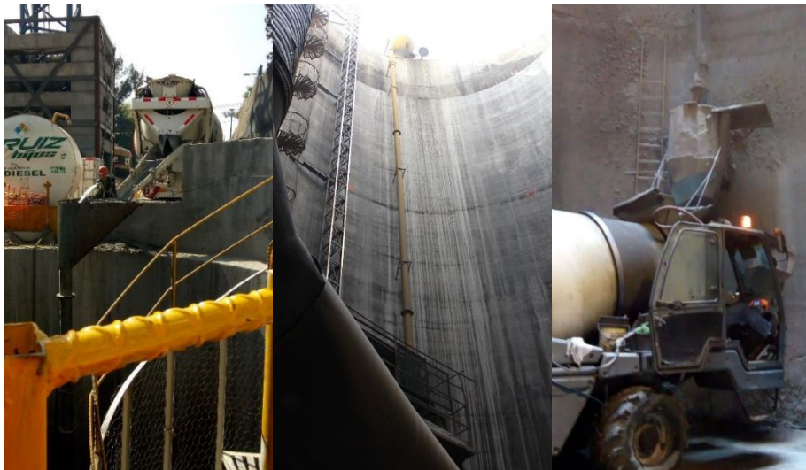
Figura 3.7: Transportación de CLR en obra.
