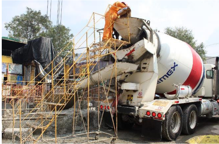
Figura 3.6: Colocación de fibras de acero en olla de concreto premezclado.
