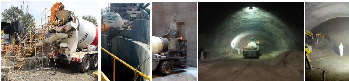
Figura 1. Procedimiento de colocación del revestimiento primario del túnel L-12
