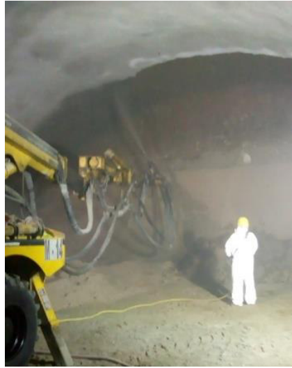
Figura 3.8: Lanzado de Concreto reforzado con fibras en Túnel, caso práctico.
