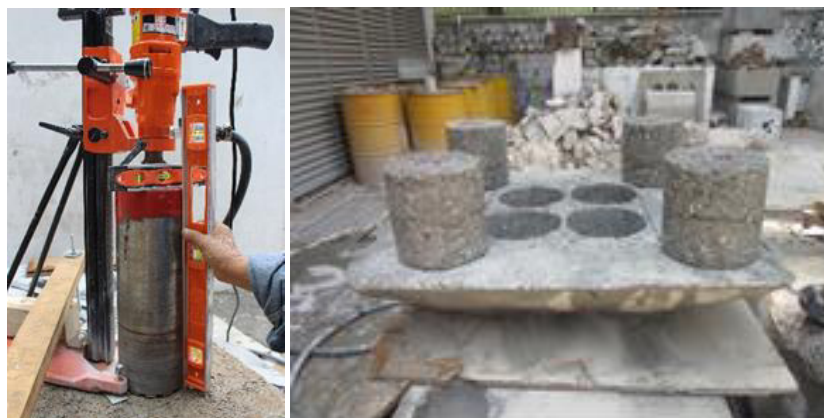
Figura 7 – Extracción de testigos para Ensayo Barcelona.
