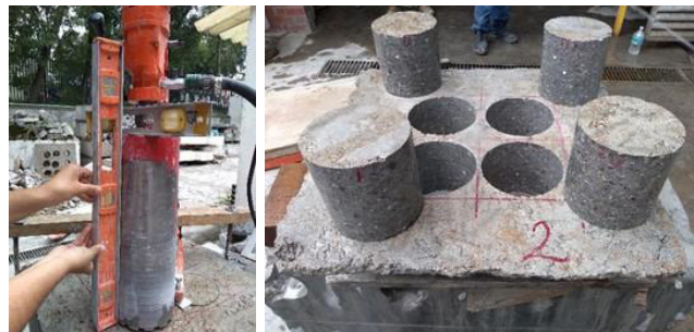
Figura 9. Extracción de testigos para Ensayo Barcelona.
