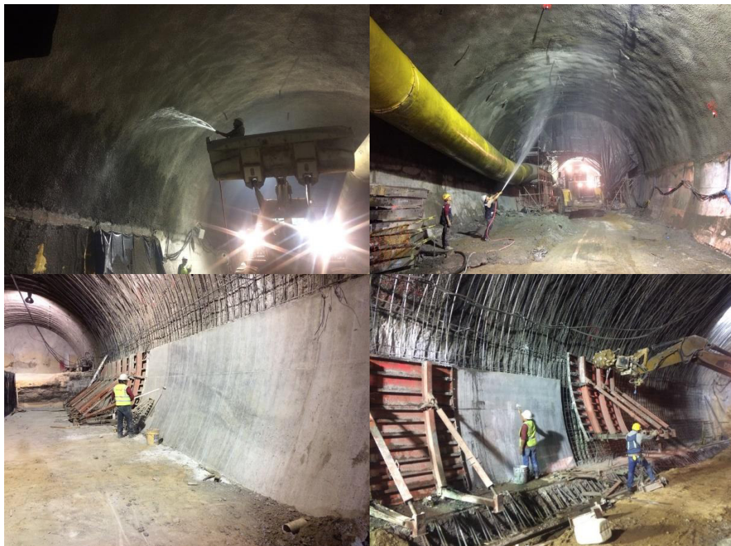
Figura 3.11: A) Curado de concreto definitivo en bóveda. B) Curado de concreto definitivo en muro hastial.
