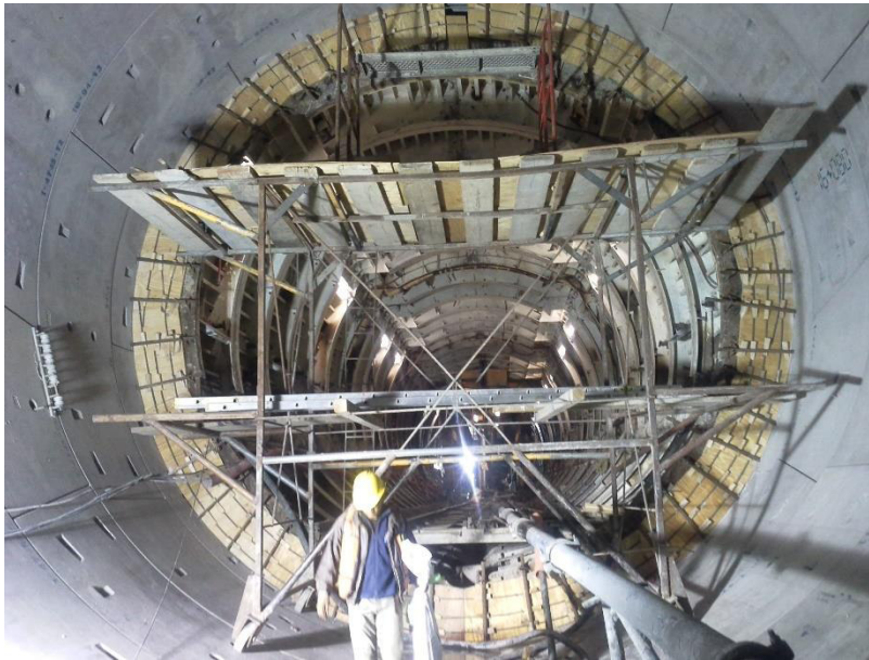
Figura 2.2: Cimbra metálica deslizable usada en la colocación de concreto reforzado con fibras sintéticas, obra: Túnel Emisor Oriente.
