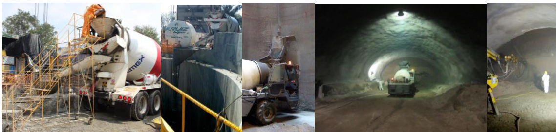
Figura 2 - Procedimiento de colocación de revestimiento primario del túnel L-12
