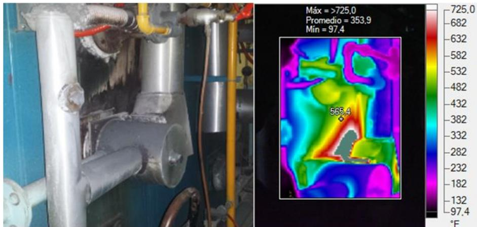
**Imagen 3. 2 Termografía en la pared posterior del horno**
