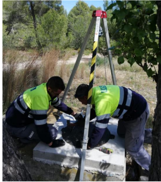
Figura 20. Cajas de agua potable (accesorios) del caso de estudio.
