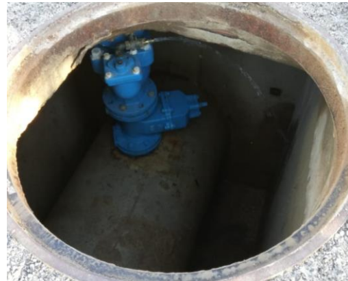
Figura 22. Toma de muestra en tubería de concreto.
