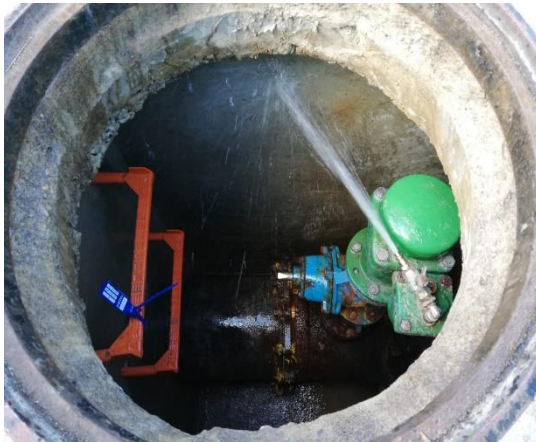
Figura 21. Toma de muestra en tubería de fundición dúctil.
