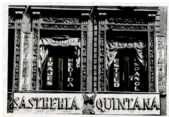
2.31 Fachada de la sastrería Quintana . Se observa un rótulo pintado a mano y luminoso, notándose los tubos de luz sobre las letras, resaltando solo una línea de la letra y no toda las características de la letra como en la parte pintado a mano. INAH (1935).
