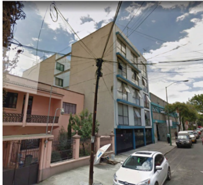
Fotografía 9 Saratoga 714. Edificio de viviendas antes del sismo. Google Maps; 2016.
