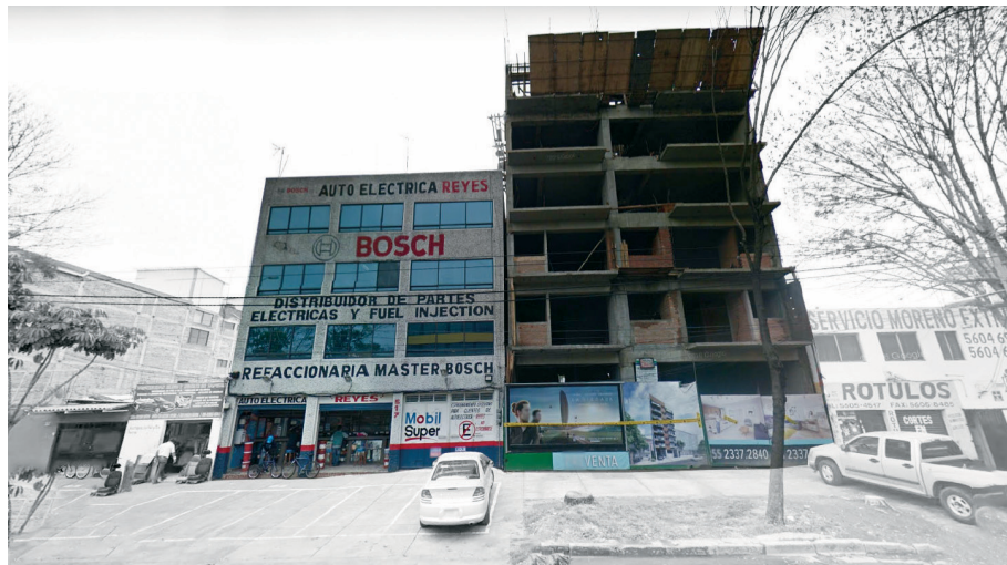
Fotografía 15 Construcción de edificio de viviendas sobre Eje Central, en donde se está dando un reciclamiento urbano, a partir de construir vivienda en predios donde antes había comercios y bodegas, principalmente dedicadas a las refaccionarias.
