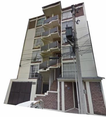
Fotografía 7 Vivienda producida por el INVI. Odesa 714. Portales Sur. Google Maps; 2018
