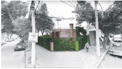
Fotografía 25 Vivienda original sobre la calle Balboa en la colonia Portales Norte. Google Maps; 2017.
