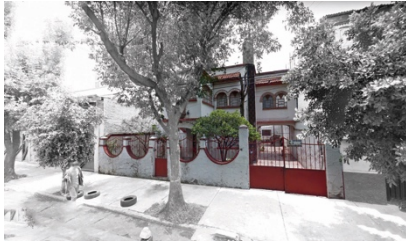
Fotografía 24 Vivienda original sobre la calle Balboa en la colonia Portales Norte. Google Maps; 2017.
