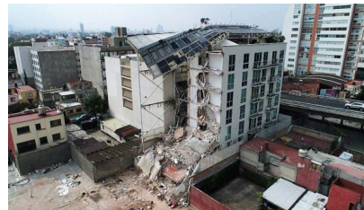
Fotografía 14 Zapata 56. Edificio de viviendas después del sismo. Nacion321.com
