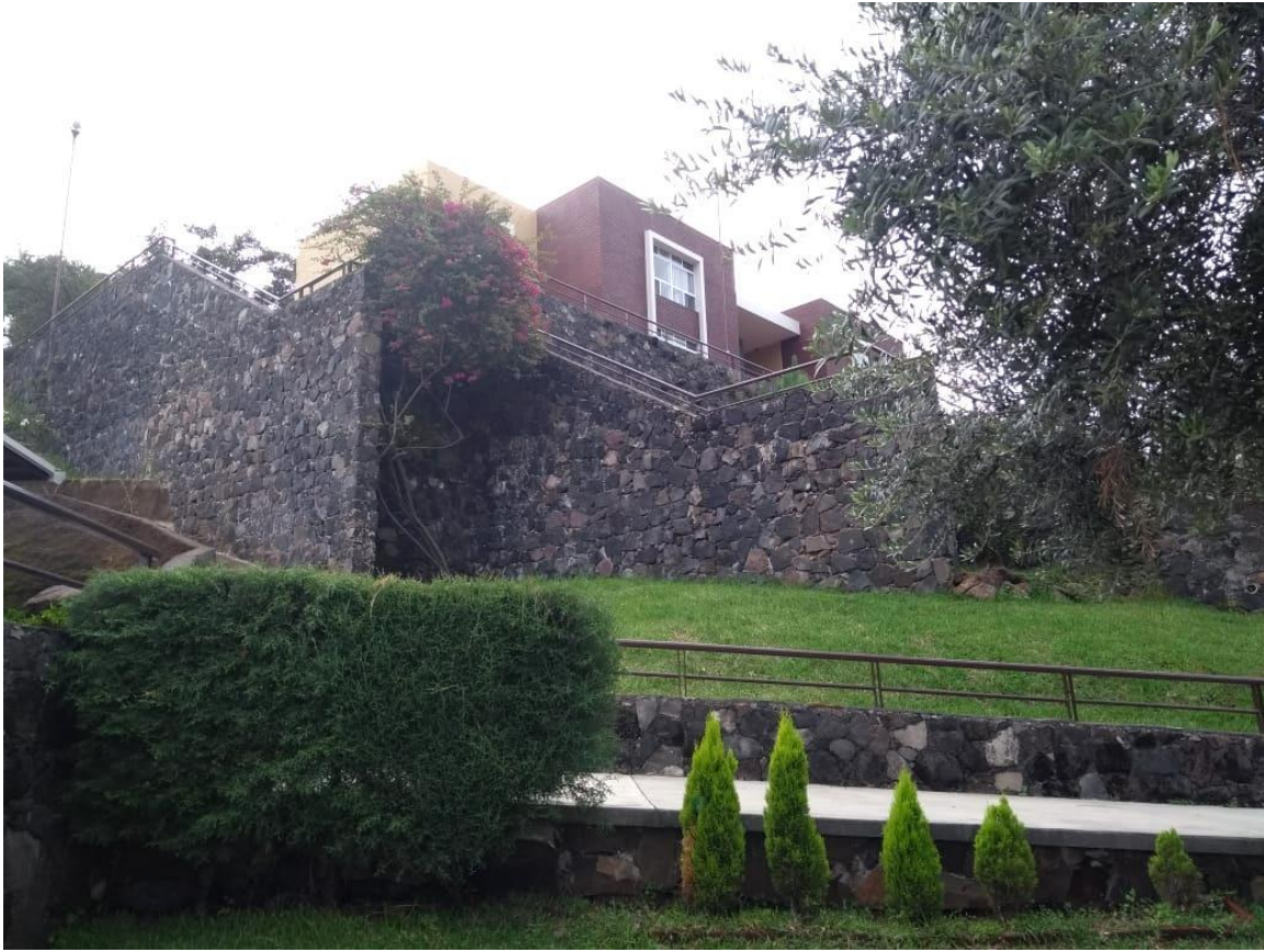
Imagen 3.7 Muro de contención 2.
