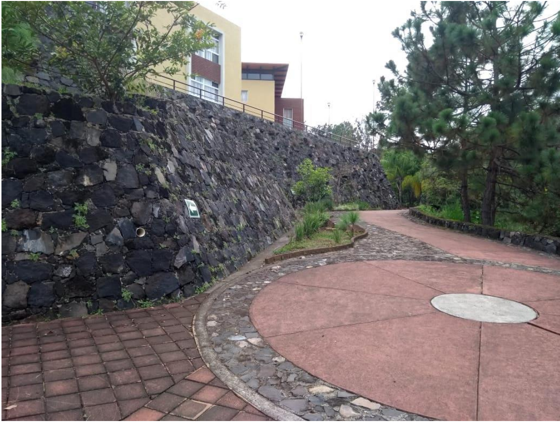
Imagen 3.8 Muro de contención 3.
