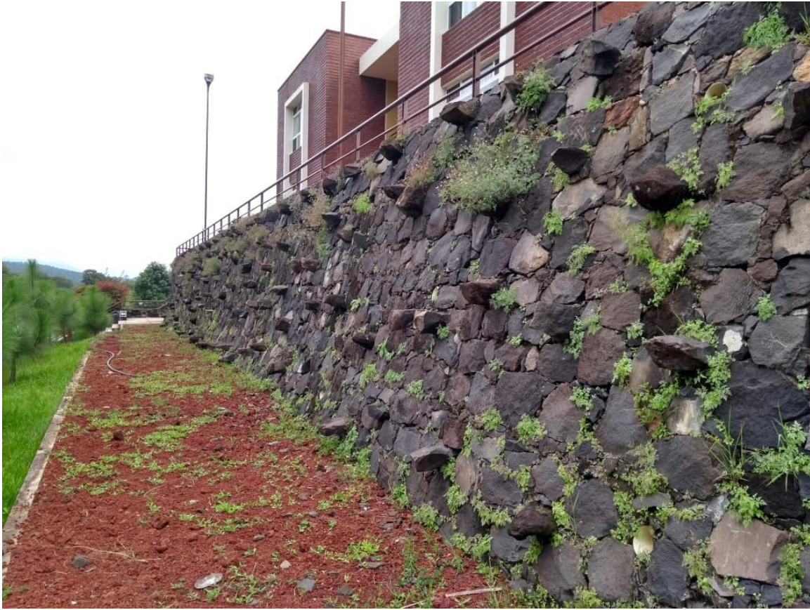
Imagen 3.9 Muro de contención 4.
