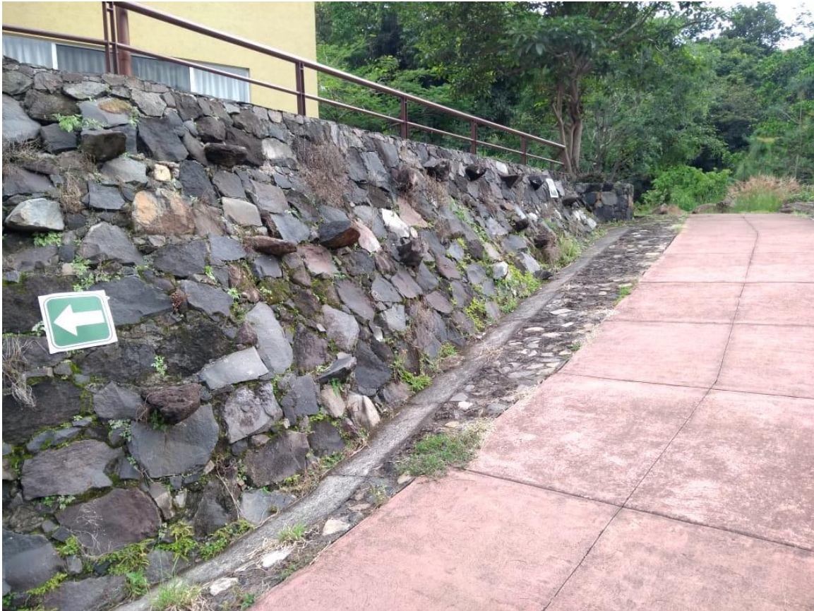
Imagen 3.6 Muro de contención 1.
