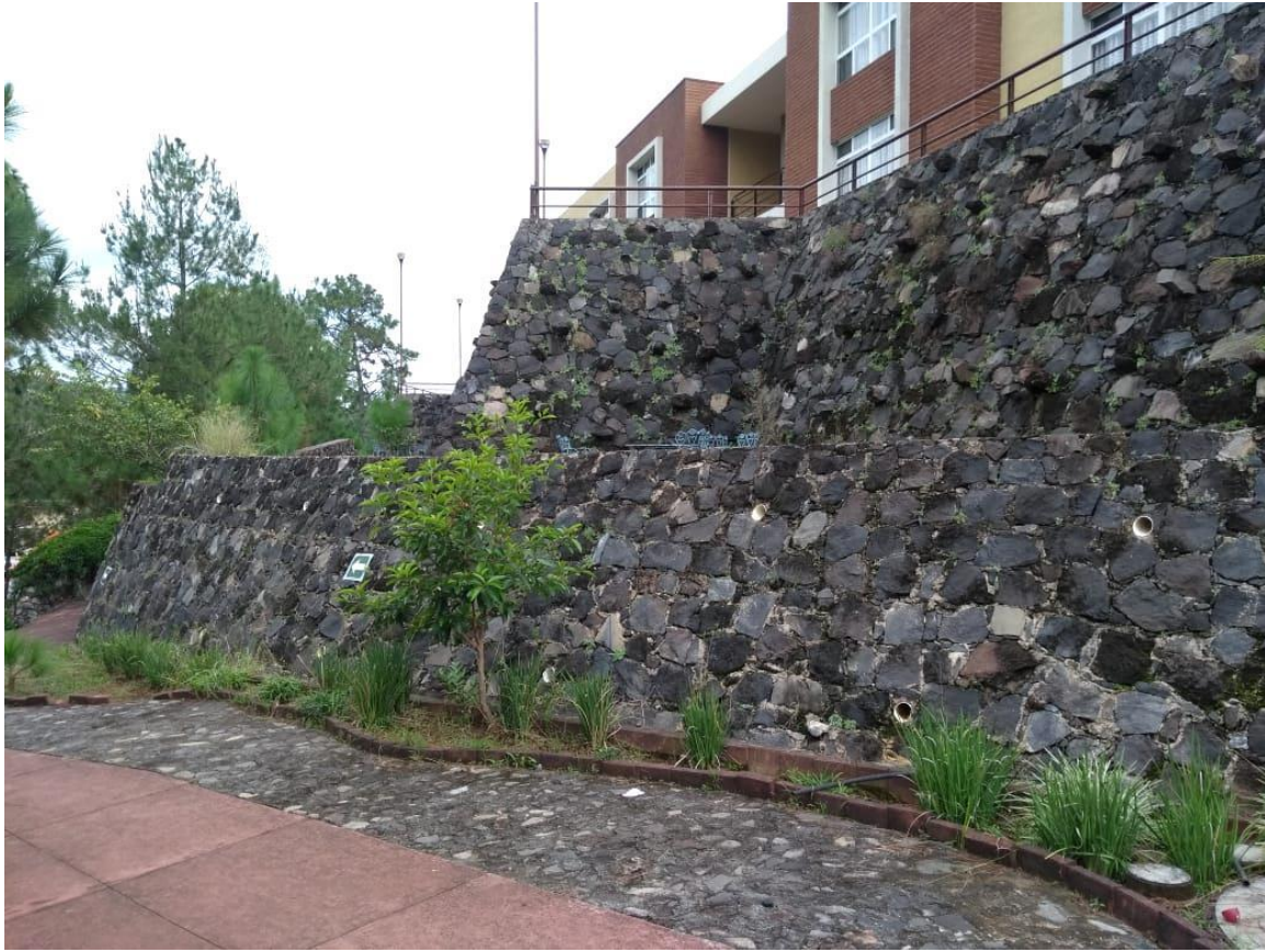
Imagen 3.10 Muro de contención 5.
