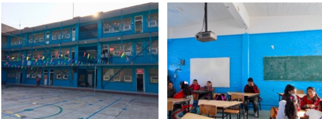
Figura 10. Edificio principal y detalle del equipo de proyección del salón de 6º, que no funciona.
