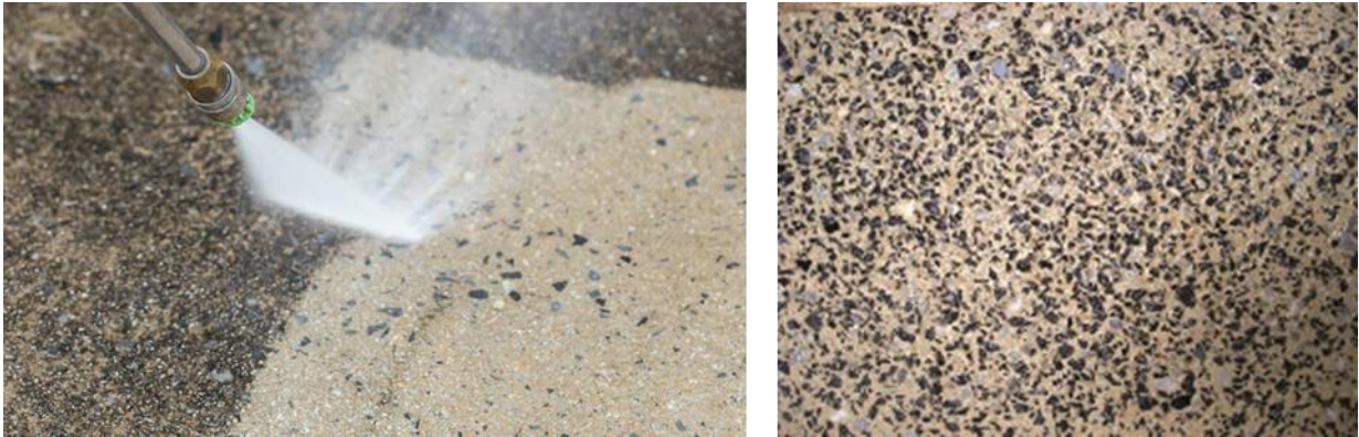
Figura 8. Acabado de concreto arquitectónico con la técnica de cepillado
