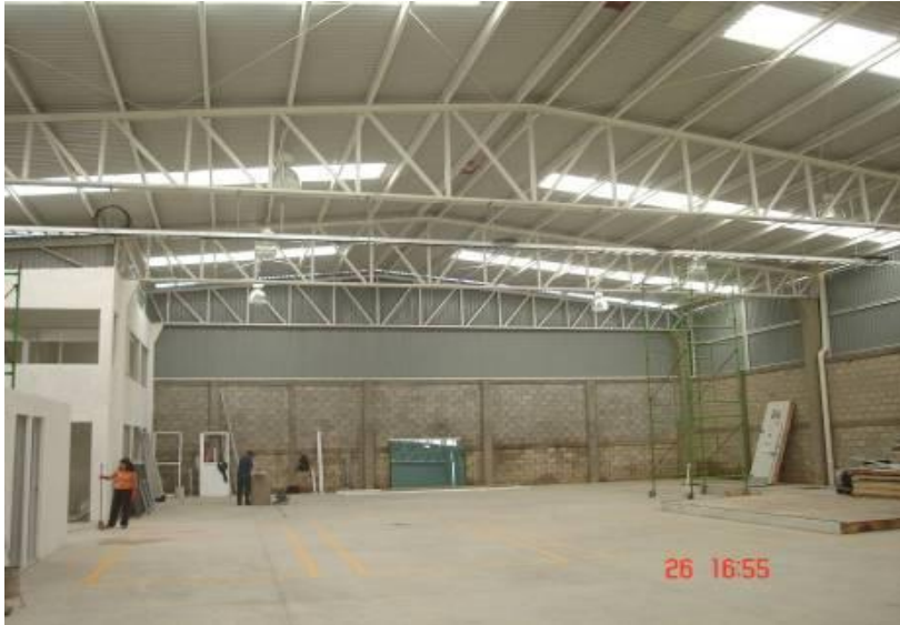
Imagen 9. Acabados de Bodega de Almacén
