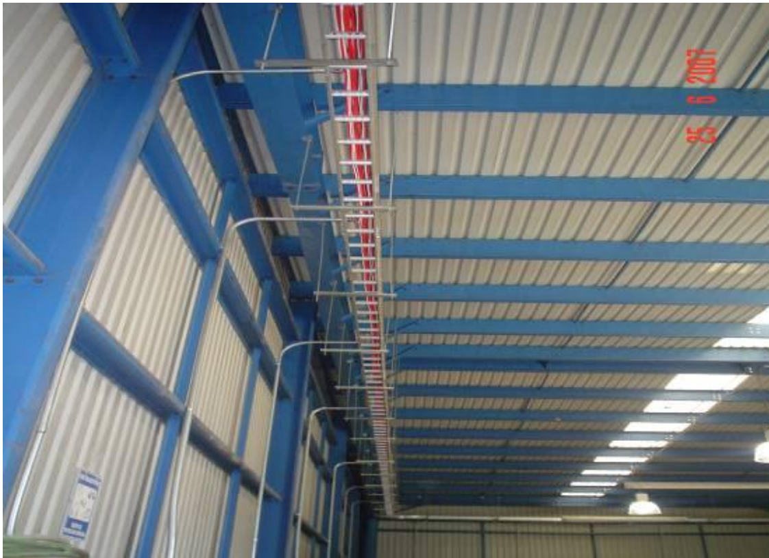
Imagen 29. Charola Aérea en Bodega
