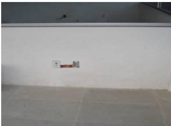
Imagen 24. Cableado a través de paredes
