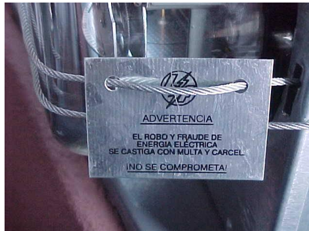
Figura 12 Medidor con sello de seguridad (arriba), (abajo) mensaje que advierte sobre el hurto de energía eléctrica.
