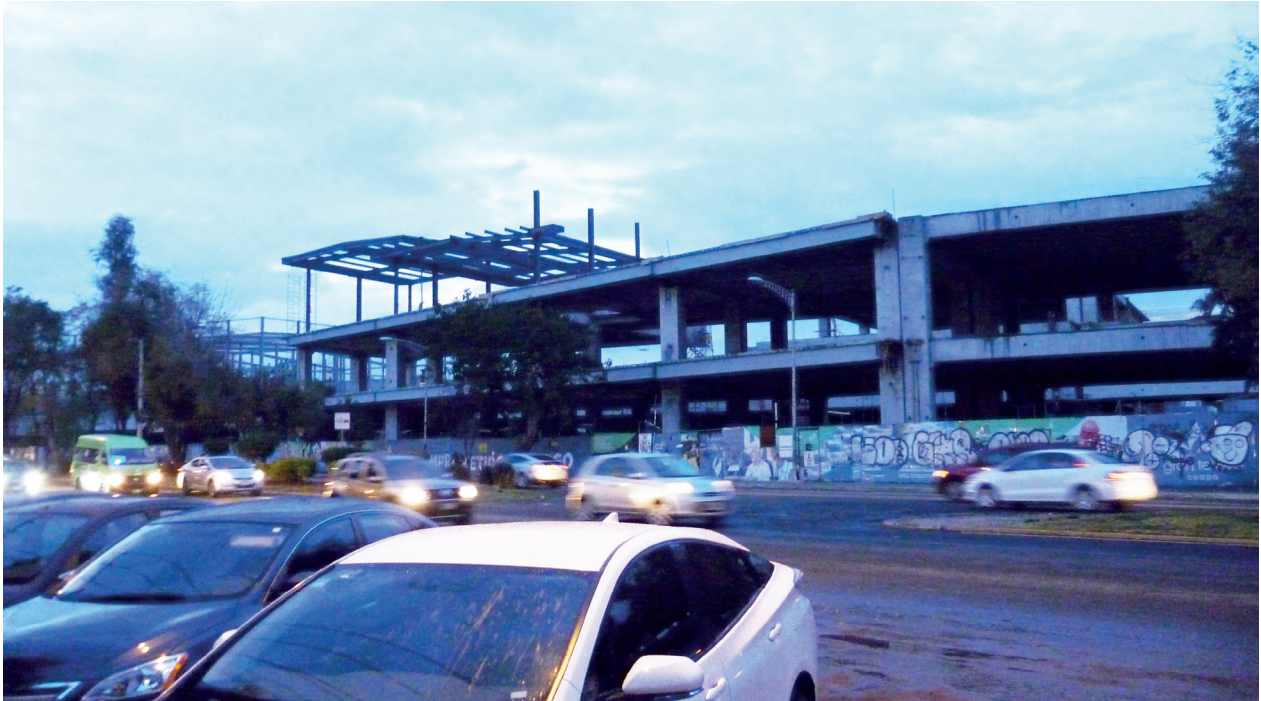
Ilustración 63. Construcción de Gran Terraza Coapa, sobre calle Acoxpa. La escala de edificio y propuesta de ciudad no se presenta en ninguna otra calle del contorno. Fuente: fotografía propia, octubre 2018.
