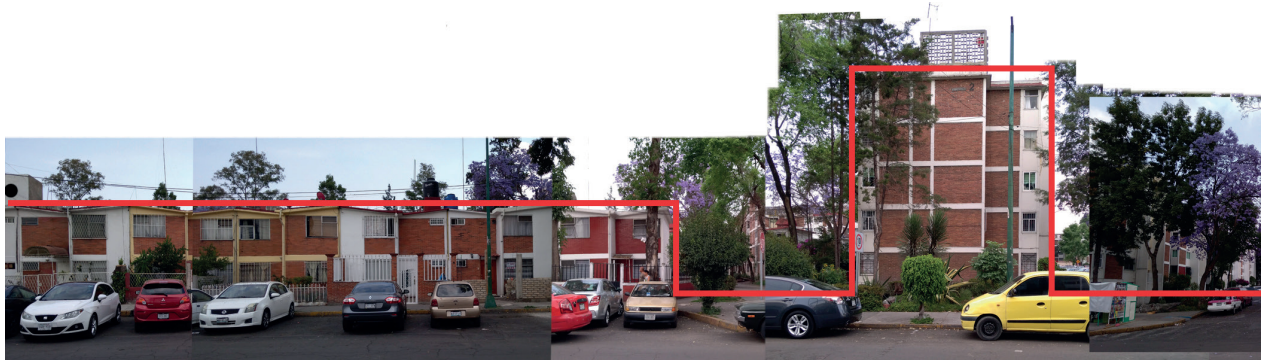
Ilustración 52. Relación de la calle con la unidad habitacional en su contorno. Calle Acequia. Fuente: Fotografía propia.
