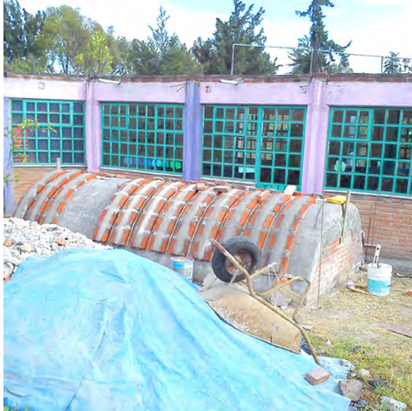
Imagen Izquierda. El molde existente de la obra de 1994 para la prefabricación de las dovelas. Derecha. Construcción del par de columnas-ladrillo.
