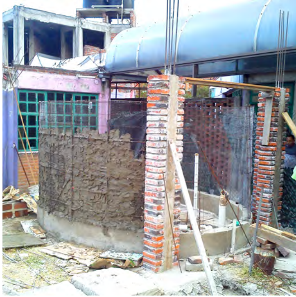
Imagen Izquierda. Sobrecimentación por medio de un anillo de desplante y armado del muro perimetral de concreto sobre metal desplegado. Derecha. Los baños con la cubierta terminada.
