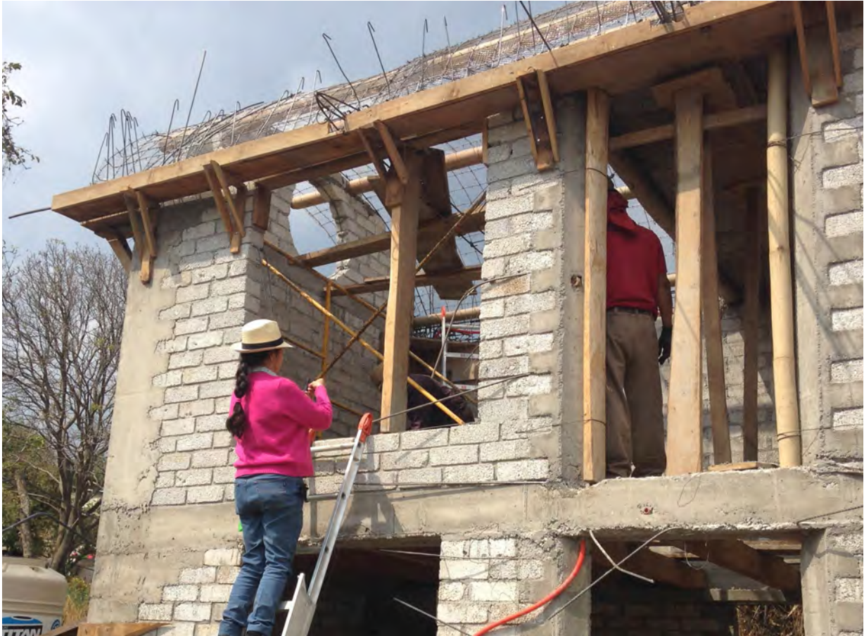
Imagen. La Dra. Ma. Eugenia Hurtado Azpeitia, frente a la gran ventana para subir los muebles, con el armado de la trabe que contendrá la carretilla.
