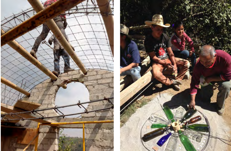
Imagen. Izquierda, los trabajos para el hueco en el tímpano donde se colocará la ventana prefabricada. Derecha, el maestro Alejandro Librado enseñando a los jóvenes a hacer ventanas con botellas recicladas de colores.
