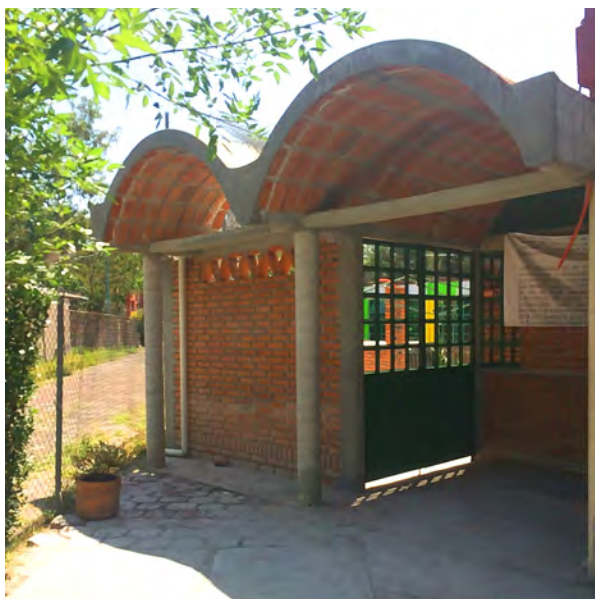
Imagen Izquierda. La plaza de acceso con la Fase 1 del crecimiento progresivo. Derecha. Interior del pasillo con los baños y el tunel de la ciencia.
