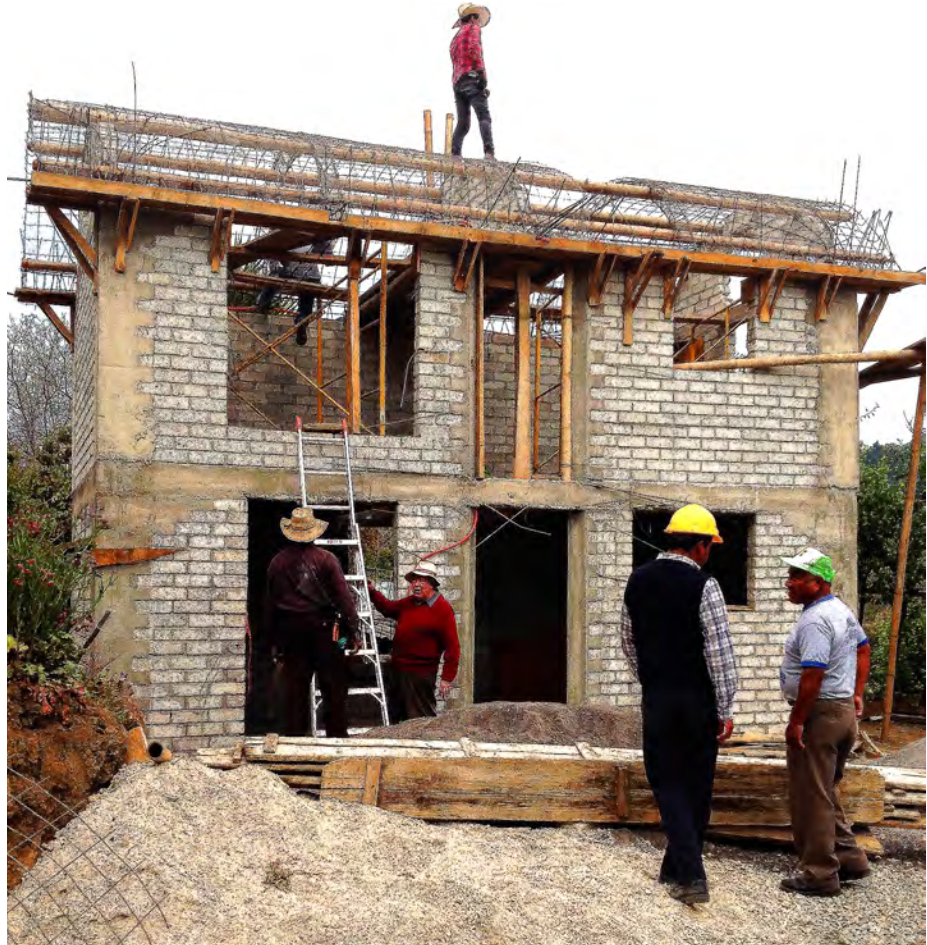
Imagen. Visita de acompañamiento de la obra del Dr. González Lobo y Ma. Eugenia, que permitieron el apoyo del maestro Alejandro Librado con los preparativos antes y durante el colado de la cubierta.
