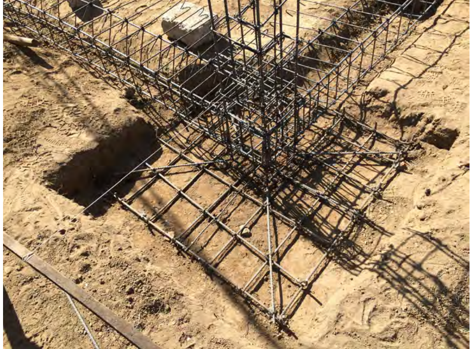
Imagen Armado de la esquina con plano sustentador, las contratraves del suelo-cimiento y la Columna-L.
