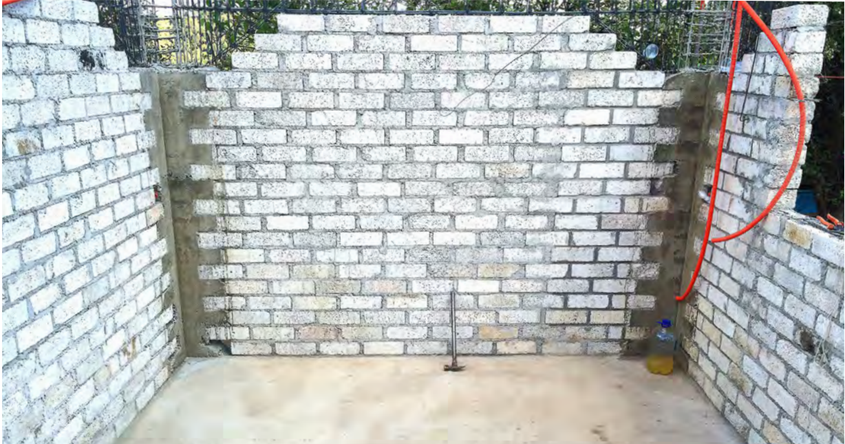
Imagen. Trabajo en obra de los tri- dros solidarios con las Co- lumnas-L dentadas.
