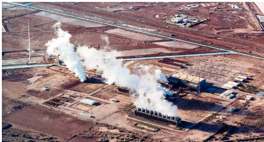
Figura 2.2. Complejo geotérmico Cerro Prieto en Mexicali, Baja California, México.
