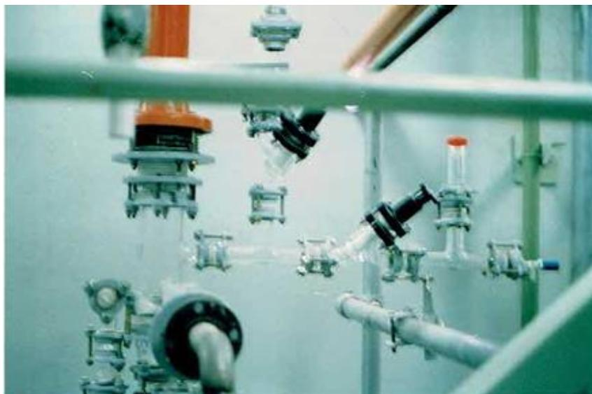
Figura 5.4. Tubería de vidrio borosilicato 3.3 utilizada para la fabricación de propranolol.
