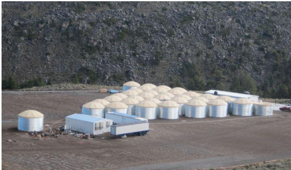
Figura 6. Etapa de desarrollo HAWC 30, con el diseño final de 30 tanques cherenkov en funcionamiento.
