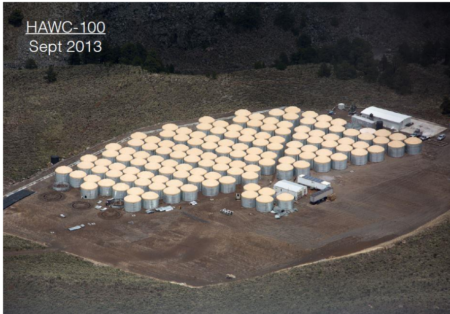
Figura 7. Etapa de desarrollo HAWC 100, con el diseño final de 100 tanques cherenkov en funcionamiento.
